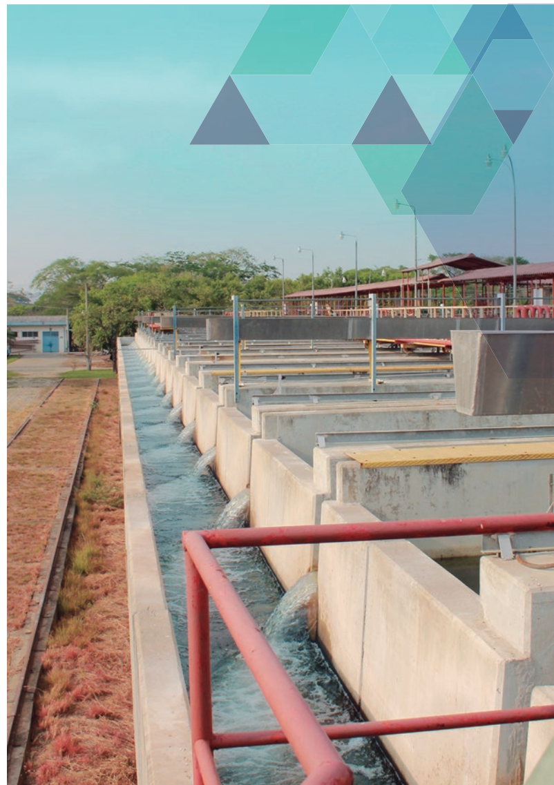
Proyecto Rehabilitación de la Planta Potabilizadora de Las Pavas, República de El Salvador
