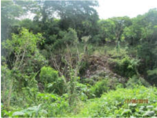
Foto anexo: Est. 0+900. Desechos sólidos sobre el trazado del camino.
