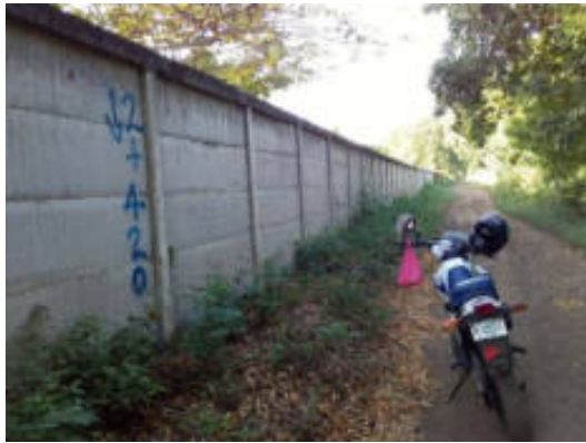
Foto anexo: marcas de la topografía sobre la ruta del trazada para la circunvalación
