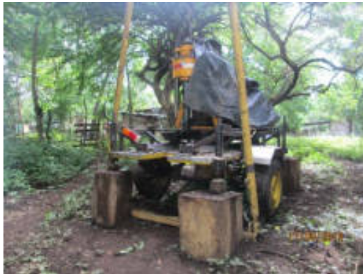
Foto anexo: Est. 0+910, máquina para los estudios de suelo en las aproximaciones del cauce El Arroyo.
