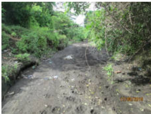
Foto anexo: Est. 0+910, Cauce El Arroyo.
