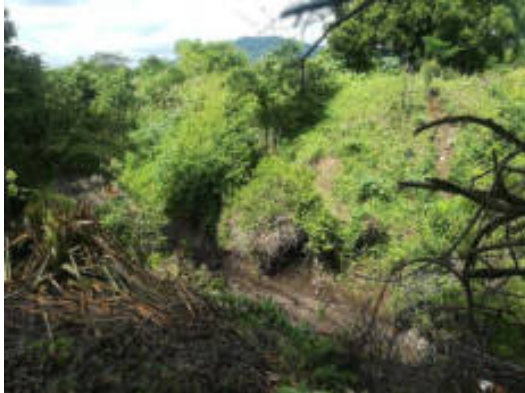
Foto anexo: Est. 0+910, Cruce por el cauce El Arroyo
