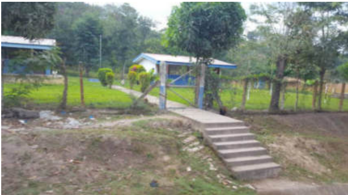
Foto 2. Escuela de Quilalí. No tiene muchos riesgos de afectación,
