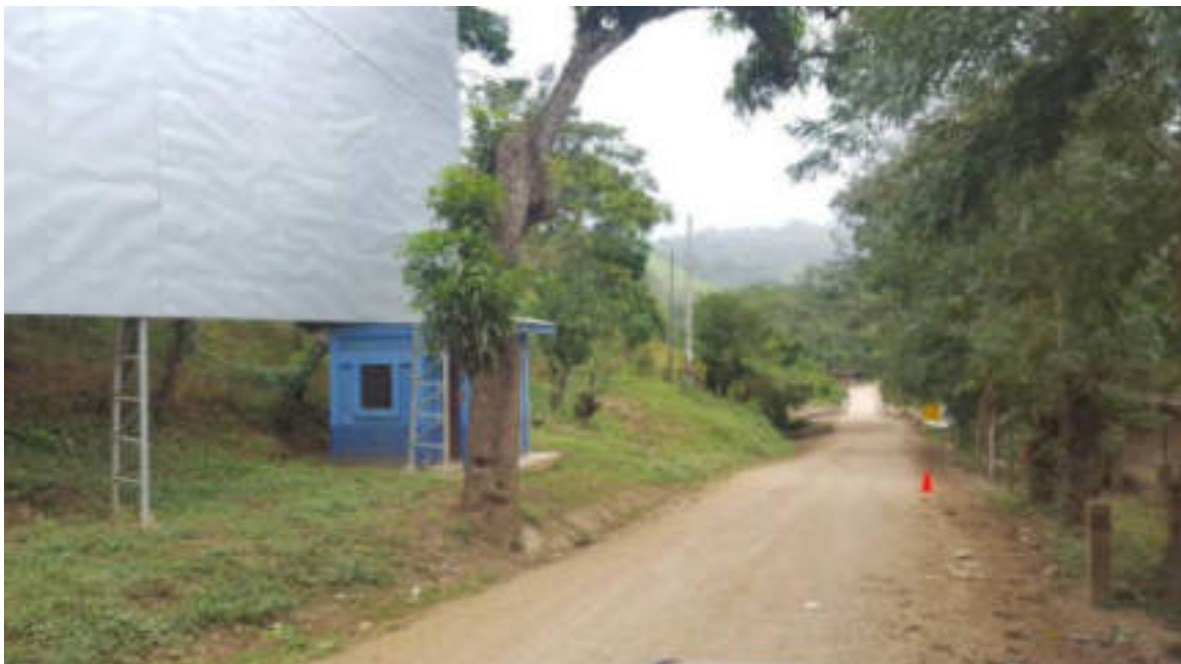
Foto 10. Trecho de carretera en su estado actual (antes del proyecto) en municipio de Wiwilí
