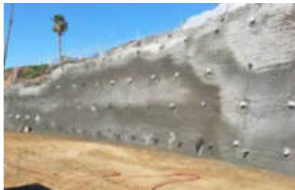
Ilustración: Ejemplo Solución Tipo II, Soil Nailing
