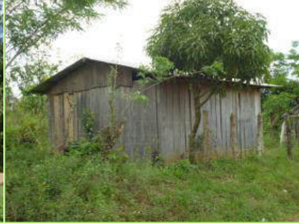
Figura 22. Propietario: Leonor Meza (Deshabitada). Esta propiedad no está declarada. Estación: 10+595 Banda: D Afectación: Total
