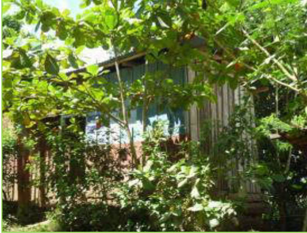
Figura 9 Propietario: Marlon Gutiérrez. Esta propiedad no está declarada. Estación: 3+674 Banda: D Afectación: Total
