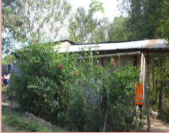
Propietario: Rigoberto Rodríguez Estación: 16+150 Banda: I Afectación: Total
