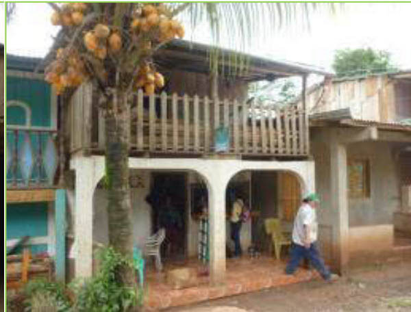
Propietario: Tomás Sevilla Mendoza Estación: 0+660 Banda: I Afectación: Parcial
