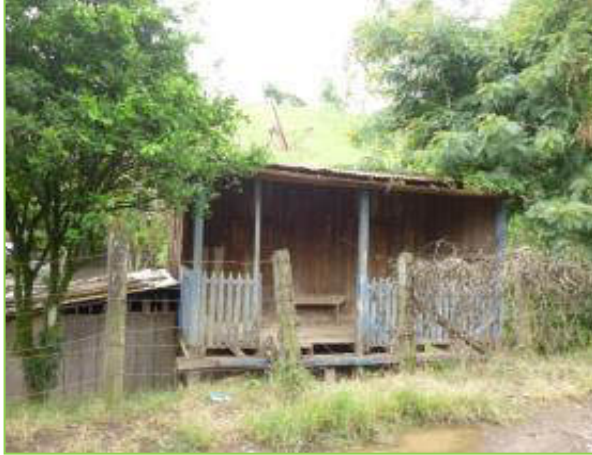
Propietario: Leonardo Ignacio Zeledón Úbeda. Estación: 11+935 Banda: I Afectación: Parcial
