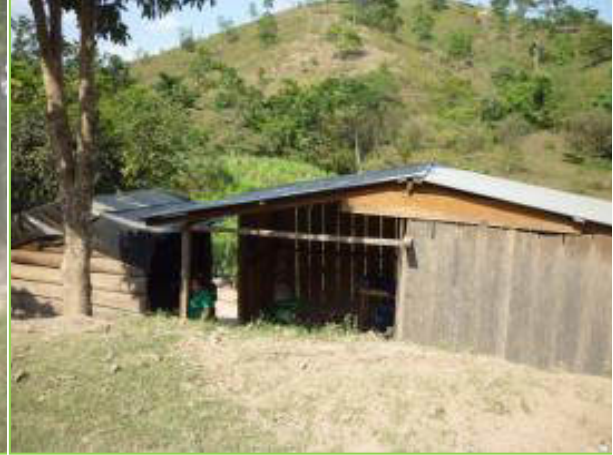
Figura 18. Propietario: Reyna Esther Castro Loasiga. Esta propiedad no está declarada. Estación: 8+010 Banda: D Afectación: Parcial
