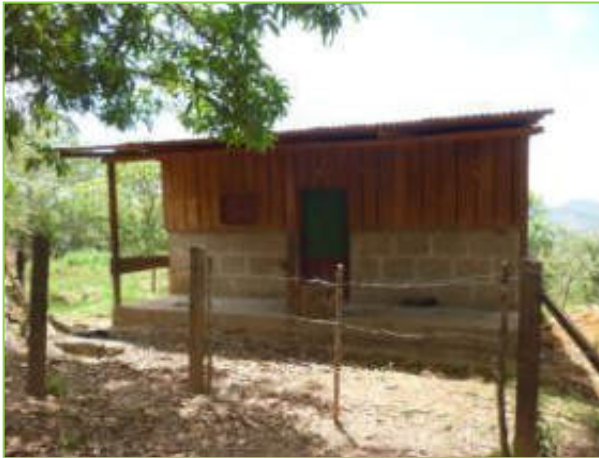
Figura 31. Propietario: Juan Pinto (Deshabitada) Estación: 22+250 Banda: D Afectación: Total Cgo. SISCAT:0707-R001001-003
