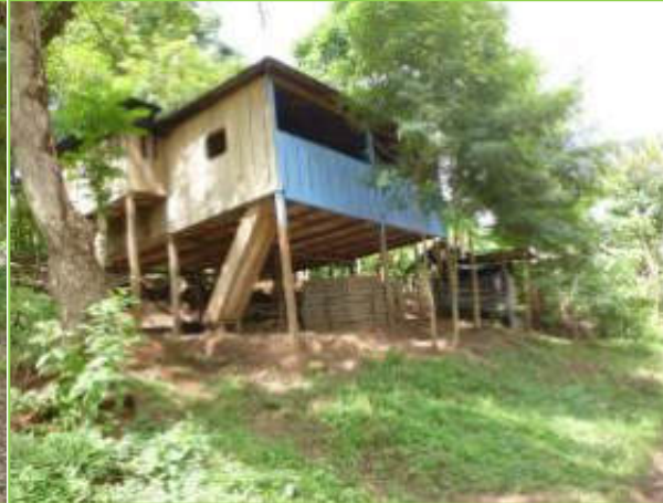
Propietario: Pedro Ramos Díaz. Estación: 16+020 Banda: I Afectación: Parcial
