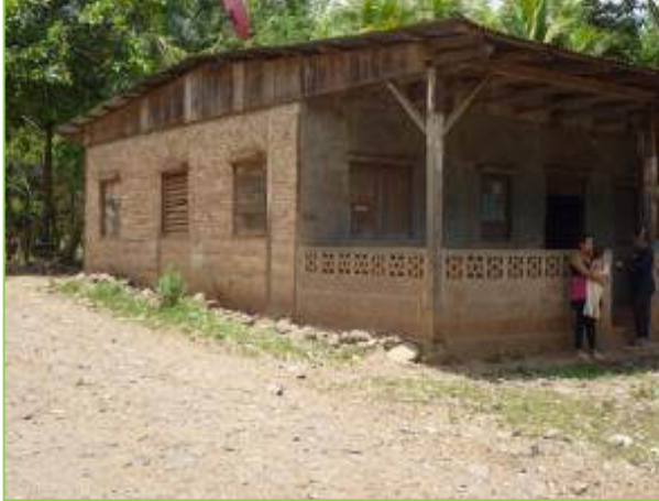
Figura 29. Propietario: Socorro Flores Estación: 18+200 Banda: I Afectación: Parcial Cgo. Siscat: 0707-R001-010-036
