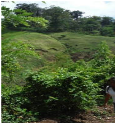
Erosión por desplome o movimiento de masa y formación de cárcava
