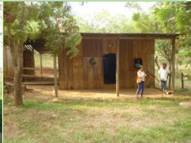
Figura 28. Propietario: Adán Roa Zeledón. Cód. SISCAT: R001-016-003. Estación: 17+300 Banda: I Afectación: Parcial
