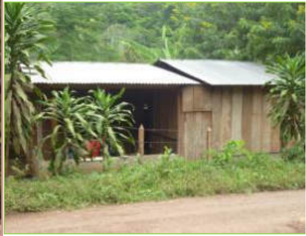
Propietario: Marlene Escorcia Zeledón Estación: 16+150 Banda: D Afectación: Total
