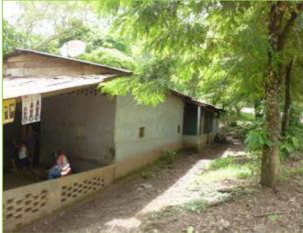
Propietario: Catalino Rodríguez Lazo/ Neidis Siomara Rodríguez Manzanarez Estación: 15+550 Banda: D Afectación: Parcial
