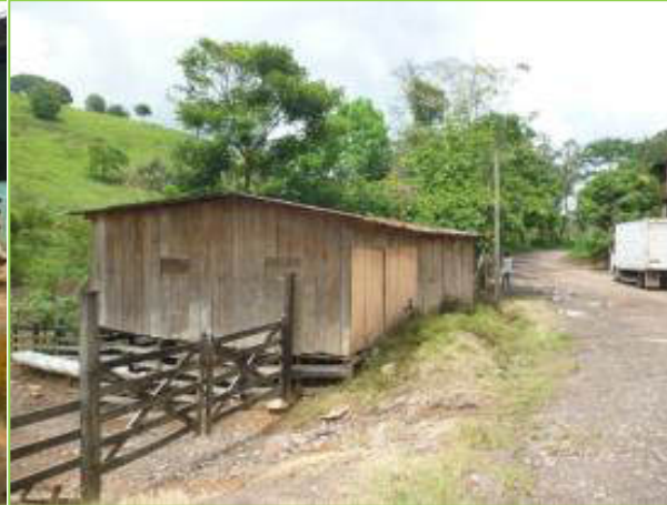
Propietario: Leonardo Ignacio Zeledón Úbeda. Estación: 11+930 Banda: I Afectación: Total
