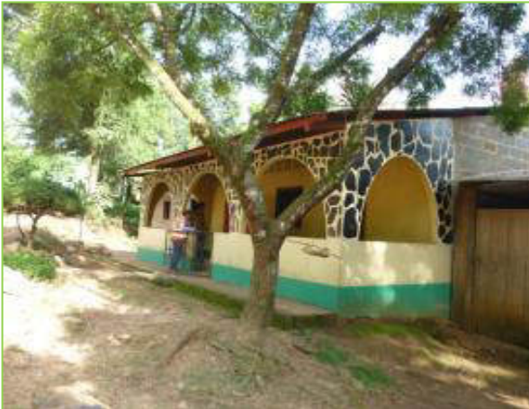
Propietario: Enrique Ríos Jerez Estación: 24+270 Banda: D Afectación: Parcial Cgo. SISCAT: 0707-U001-009-007
