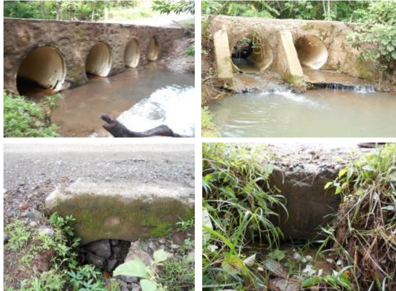
Figura 5.5.a: Tipo de Alcantarillas
