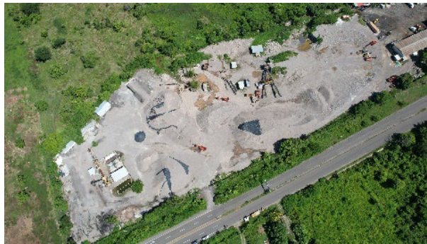
Figura 41. Trituradora de piedra al inicio del proyecto. Foto: Vielca Ingenieros
