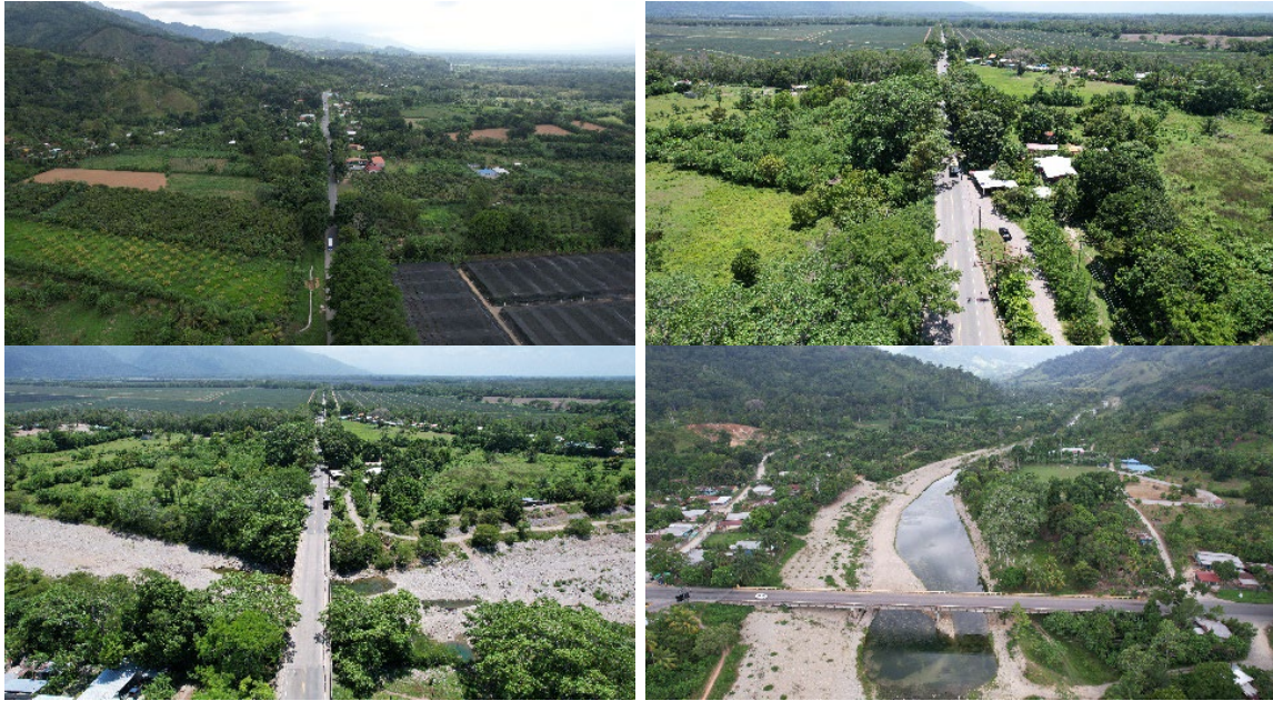
Figura 40. Imágenes del tramo 3. Fotos: Vielca Ingenieros
