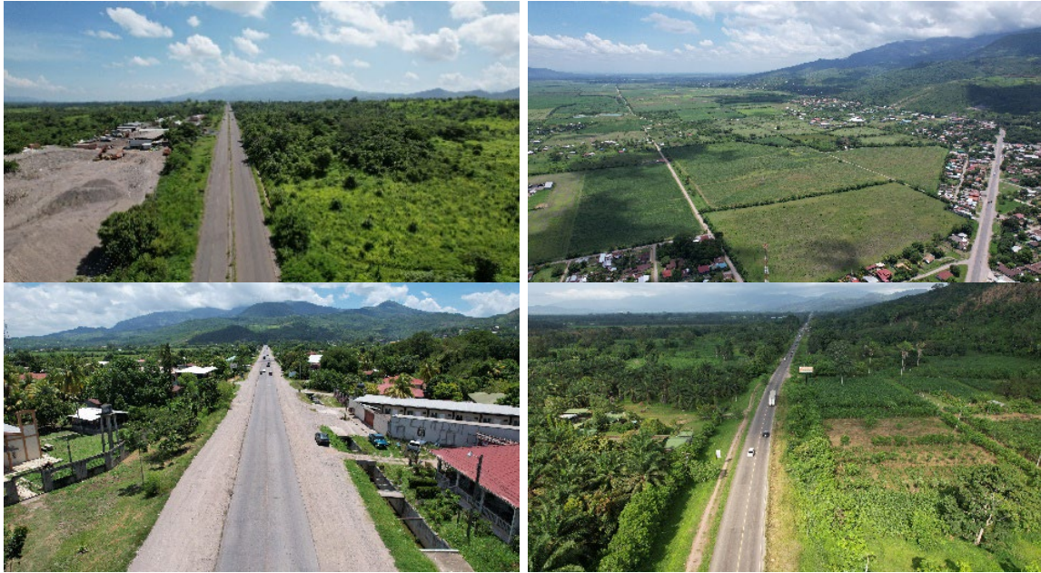
Figura 38. Tramo #1, "La Barca" - "El Progreso". Fotos: Vielca Ingenieros.
