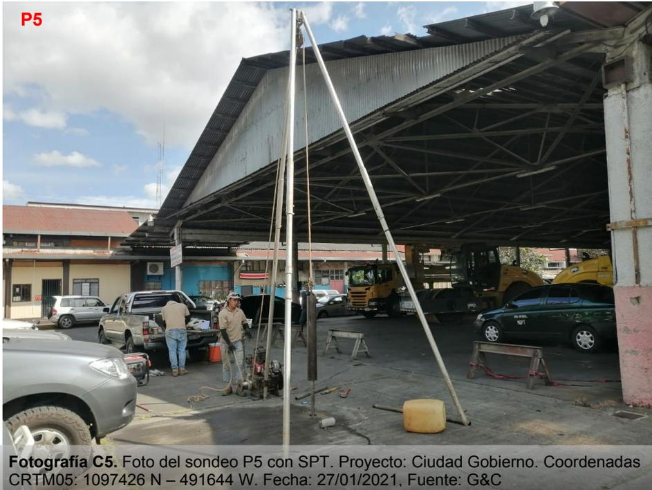
**Fotografía C5.** Foto del sondeo P5 con SPT. Proyecto: Ciudad Gobierno. Coordenadas CRTM05: 1097426 N – 491644 W. Fecha: 27/01/2021. Fuente: G&C
