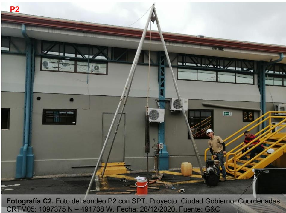
**Fotografía C2.** Foto del sondeo P2 con SPT. Proyecto: Ciudad Gobierno. Coordenadas CRTM05: 1097375 N – 491738 W. Fecha: 28/12/2020. Fuente: G&C
