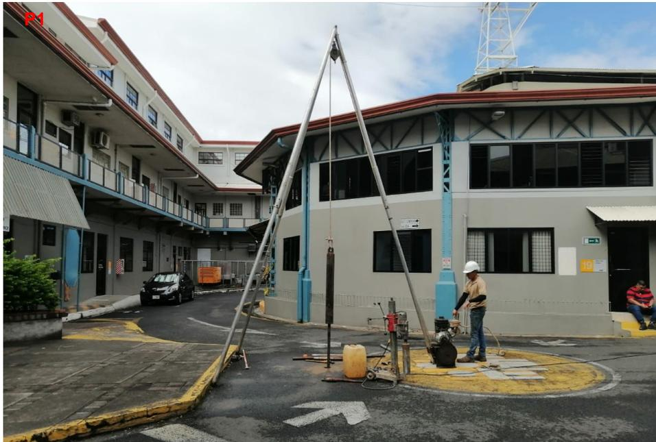
**Fotografía C1.** Foto del sondeo P1 con SPT. Proyecto: Ciudad Gobierno. Coordenadas CRTM05: 1097324 N – 491734 W. Fecha: 28/12/2020. Fuente: G&C
