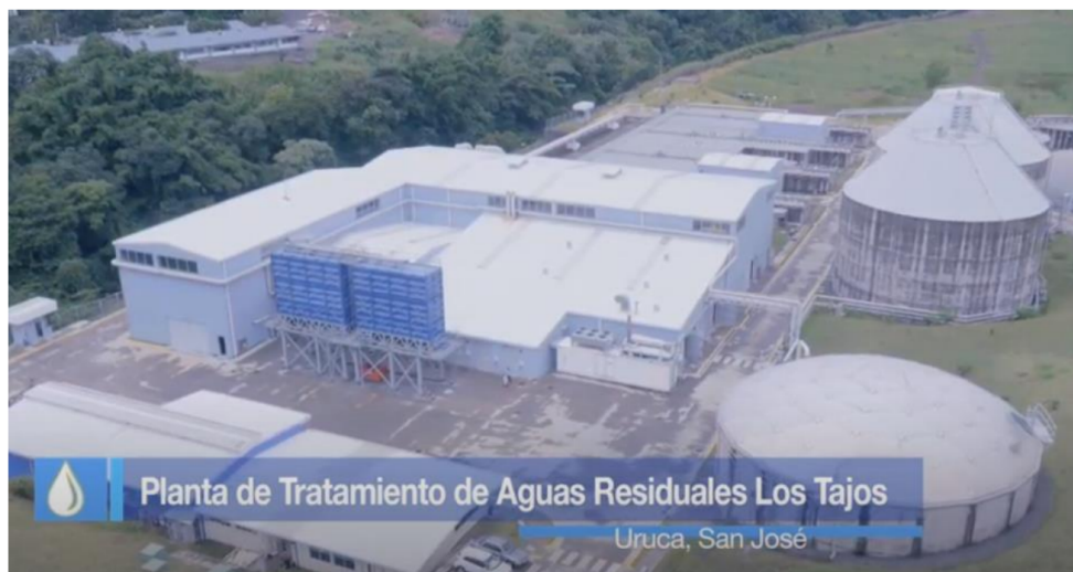
Figura 20. Planta de Tratamiento de Aguas Residuales Los Tajos, AyA.
