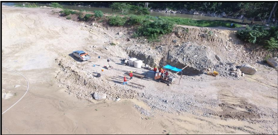
Fotografía No. 17 Perforaciones de Investigaciones en cercanías al río Ulúa
