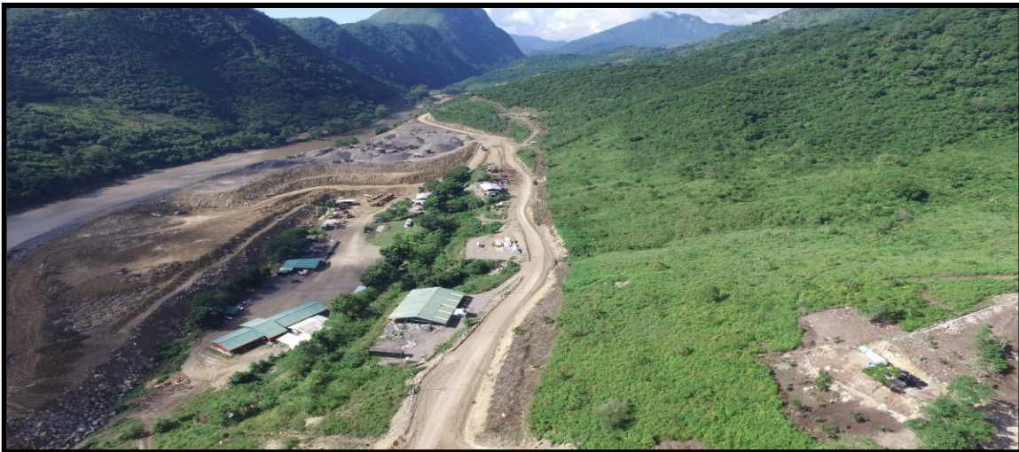
Fotografía No. 13 Instalaciones para Talleres, Laboratorio y Oficinas
