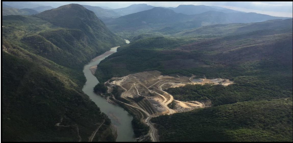
Fotografía No. 14 Vista Desde Aguas Abajo de Excavaciones Margen Izquierdo
