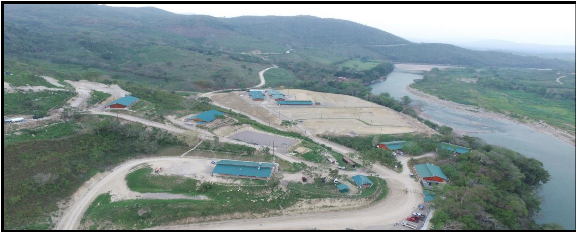
Fotografía No.12 Vista de Oficinas y Campamentos
