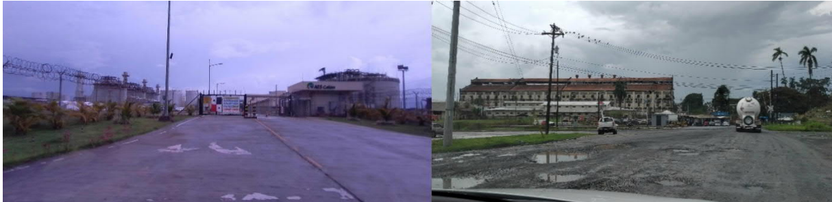
Planta de Gas Natural y vía de acceso al área de proyecto
