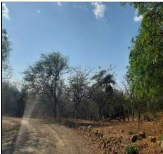
Ilustración 6 Inicio Tramo V Est. 113+480
