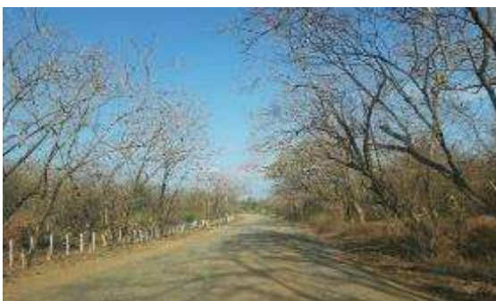
Ilustración 6 Inicio Tramo IV
