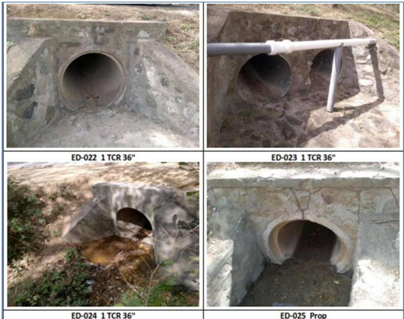
Ilustración 6 Obras de Drenaje menor existente en el tramo II
