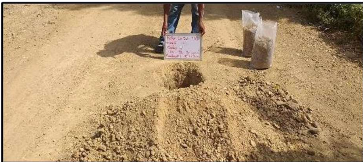
Ilustración 16 Apertura de Calicata Sondeos Manuales (Fotografía Fuente Estudio Geotécnico)
