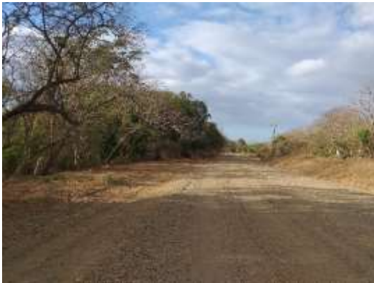
Ilustración 6. inicio Tramo III Est 53+300
