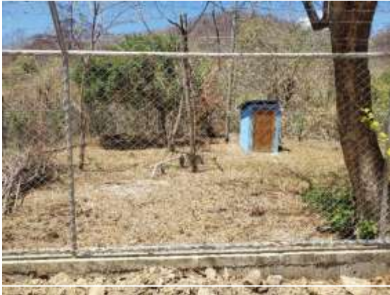
Fotografía 21. Pozo de agua potable en comunidad de El Ostional
