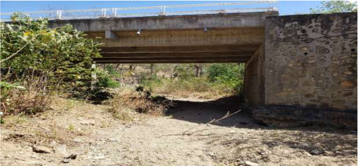
Fotografía 3. Condiciones actuales Puente El Pochote Est.3+400.
