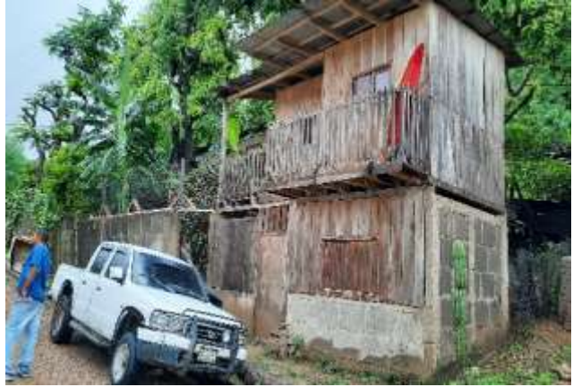
Fotografía No.20. Vivienda sobre el derecho de vía Est.10+010 Propietario Juan Collado
