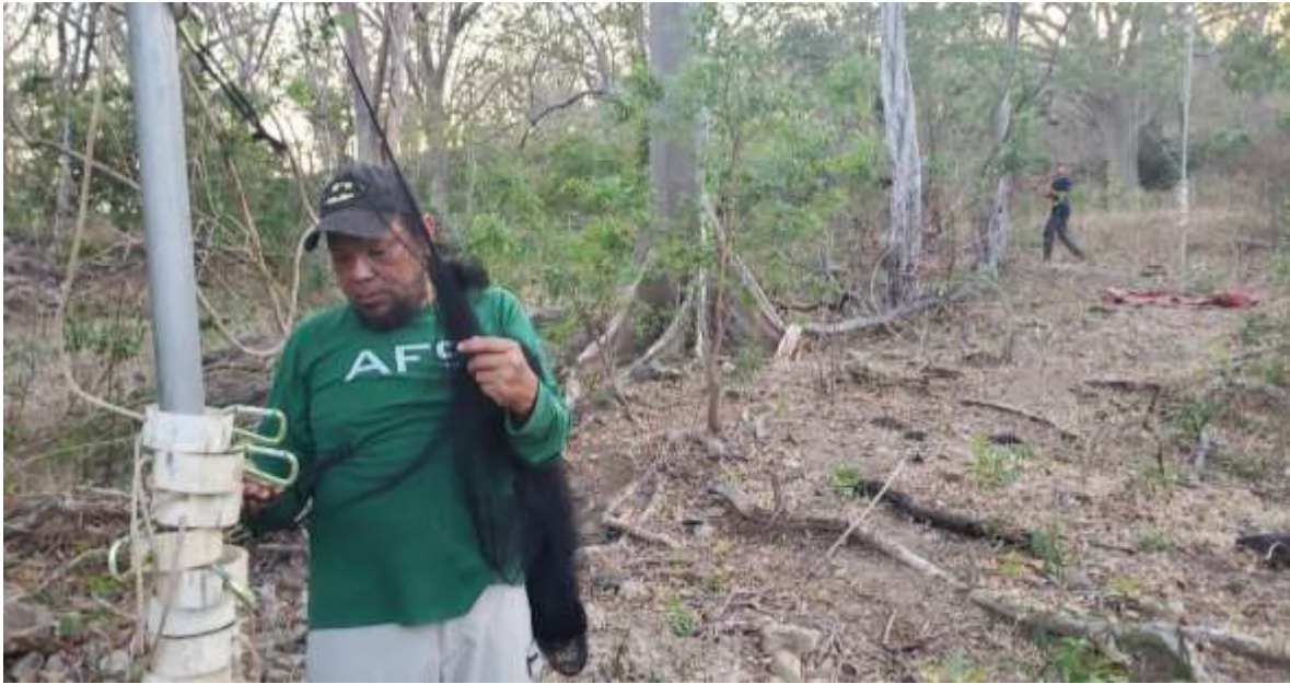
Fotografía 12. Instalación de red de niebla en sector de El Pochote.
