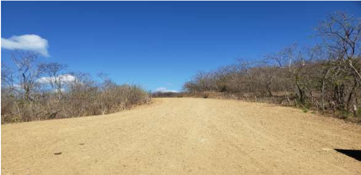
Fotografía 1. Condiciones actuales del tramo en la Est.0+500.
