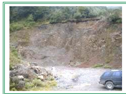
Fotografía 16 en la Estación 19. Cantera de caliza brechada. Se nota la deformación y fracturamiento de la caliza cercana al contacto con la lutita verde.
