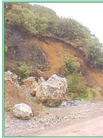
Fotografía 21 Caídas de bloques de caliza y arrastre de detritos en los laterales de la ruta San Sebastián Coatlán– Pet.
