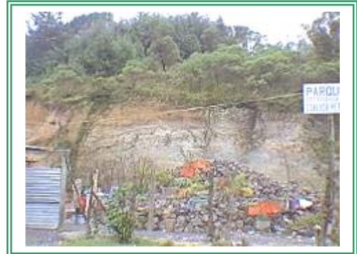
Fotografía 18 en Estación 22. Aflojamiento de lutita verde en capas subhorizontales.
