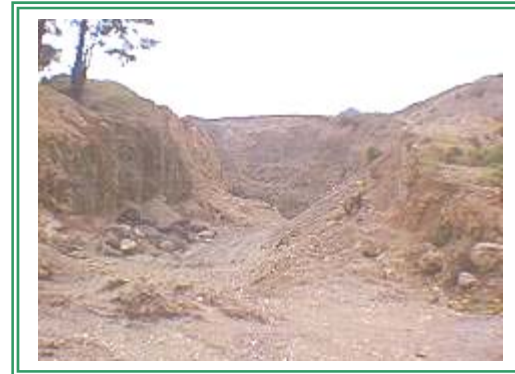
Fotografía 14 en Estación 17. Cantera de caliza, área sujeta a erosión que afecta al camino que pasa perpendicular a su entrada.
