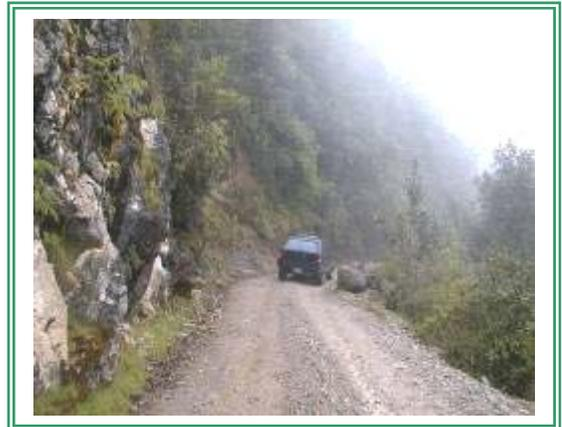
**Fotografía 23.** Punto observado 39, Caída de bloques en tramo estrecho del camino
