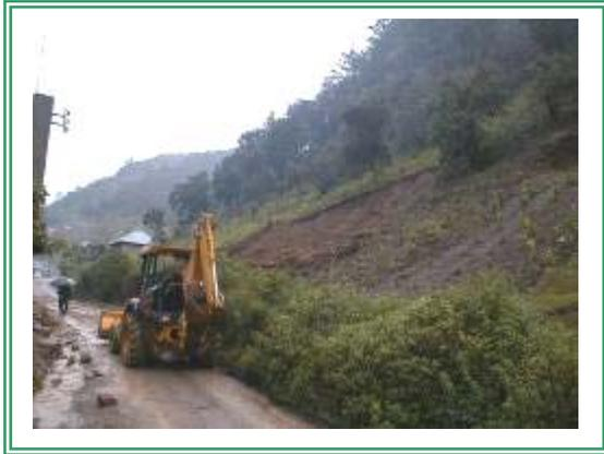
**Fotografía 26** Punto observado 44. Deslizamiento de terreno situado en una zona de falla. Se observan evidencias de actividad y recurrencia problemática. Requiere de trabajos de estabilización. Punto crítico para mantener la vía expedita.
