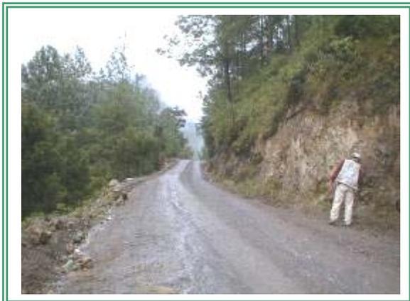
**Fotografía 16.** Punto observado 24, tramo de camino muy estrecho en caliza brechosa. Desprendimiento de bloques deaueños.
