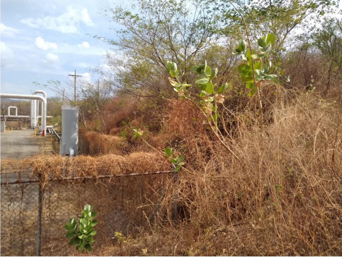
Ilustración 14. Vista desde el punto L22 a L23 conforme plano SJTU5-0MA-002-REV2 en sentido norte- sur. Contiguo a la malla por la parte externa pasará el tramo de tubería que acarreará la salmuera, se logra ver que es una zona con predominancia de matorrales que además se ha incluido la protección de taludes en la zona Oeste.
