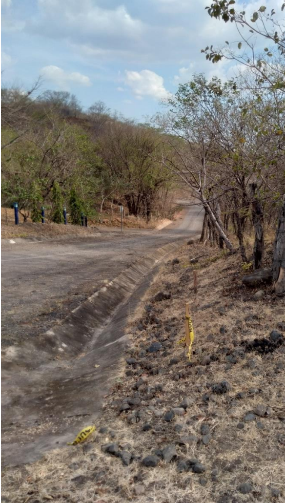
Ilustración 19. Vista desde L14 a L13 según plano SJTU5-0MA-002-REV2 Norte a Sur. Para minimizar el impacto se ha trazado el tramo de tubería paralelo al camino existente.
