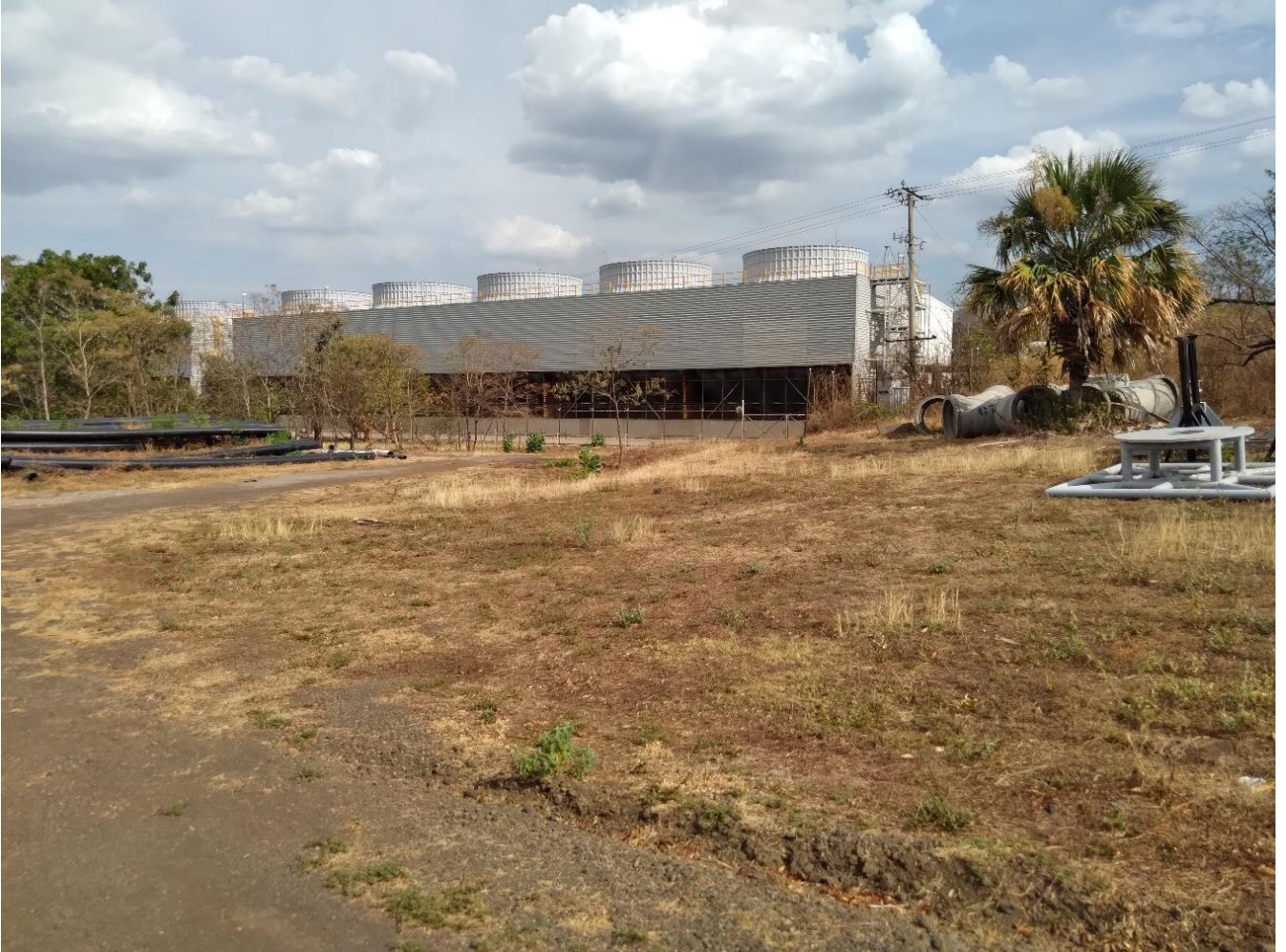
Ilustración 13. Área donde se instalará la estación de químicos y conexión de la tubería de acarreo de salmuera
