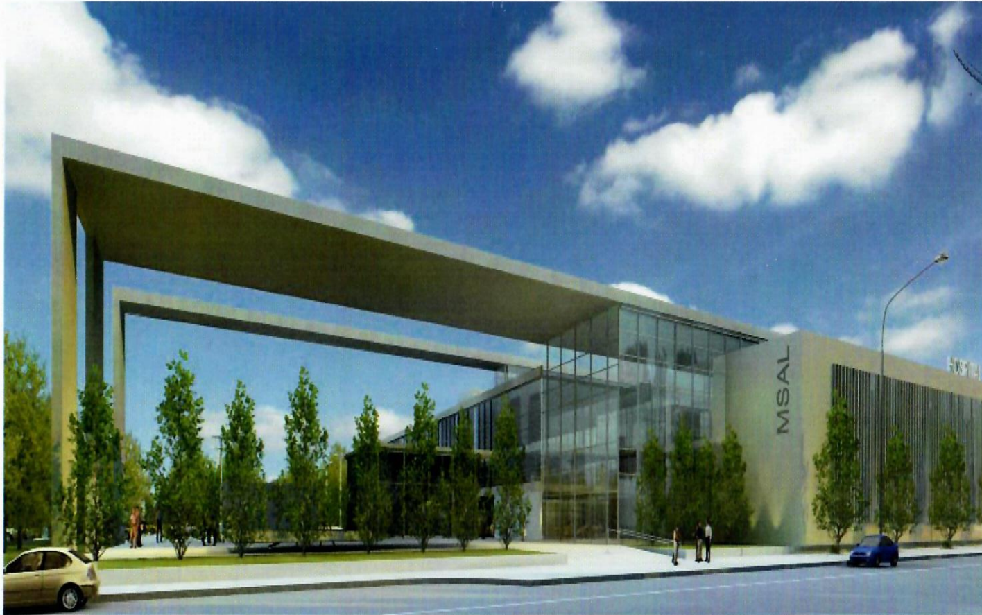
Figura 2.4. Acceso principal sobre la calle C. F. de Brandsen
