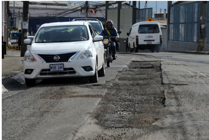
Figura 9.4.15. Vía intervenida en Tirrases de Curridabat
