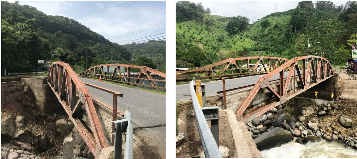
Figura 9.5.24. Puente sobre Ruta 224, paso sobre río Aguacaliente, entrada a cantón de Orosi, Cartago
