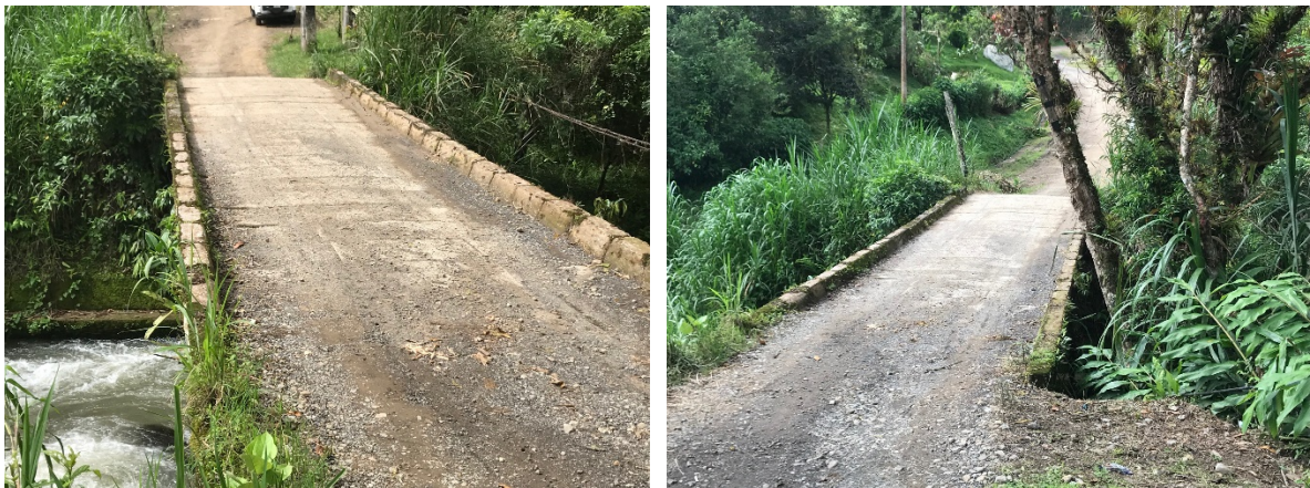
Figura 9.5.30. Puente sobre río Navarro. Ruta 405, Navarro El Socorro, Cartago.
