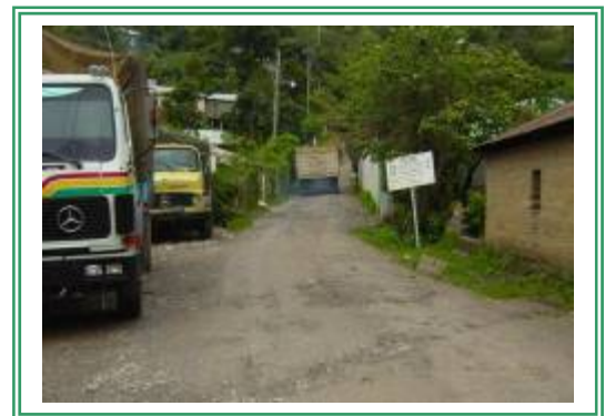
Fotografía 36. Obsérvese el ancho de rodadura de la carretera en servicio, en varios tramos no es posible el paso simultáneo de dos vehículos.
