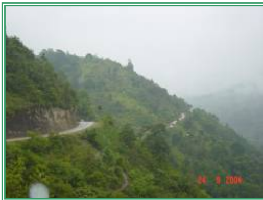
Fotografía 48: Obsérvese la peligrosidad de la carretera en algunos puntos.
