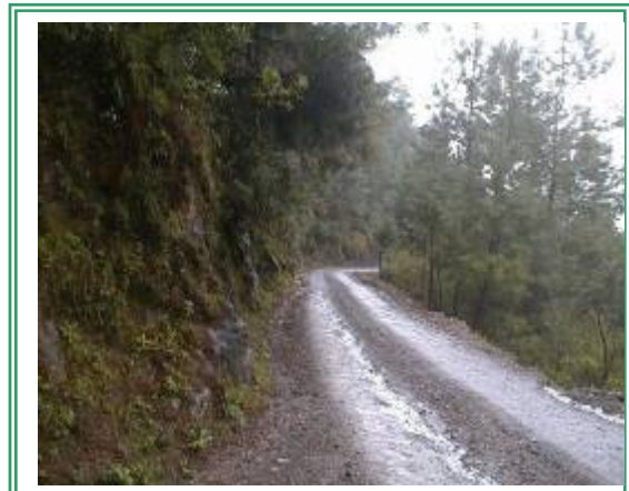
Fotografía 25. Punto observado 42. En este tramo el camino se vuelve de un carril debido al afloramiento de roca caliza dura.
