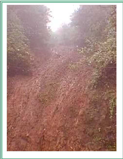
Fotografía 24. Punto observado 41. Zona de suelos gruesos sobre caliza. Formación de flujos de lodo. Porción estrecha del camino.
