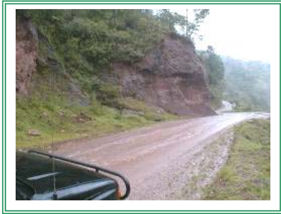
Fotografía 14. Punto observado 14, zona fracturada en capas rojas, caída de detritos. Sitio de extracción de arava gruesa de los conglomeraos.
