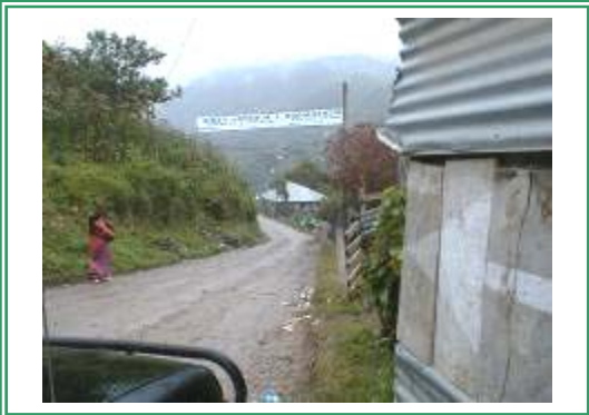
Fotografía 8. Inicio del tramo en la salida de San Miguel Acatan. Camino de terracería de unos 5-6 m de ancho con mantenimiento adecuado.
