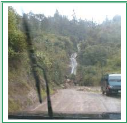
Fotografía 12. Punto observado 10, caída de bloques en zona adyacente a quebrada. Badén estrecho sobre el camino, acumulación de bloques y sedimentos finos.
