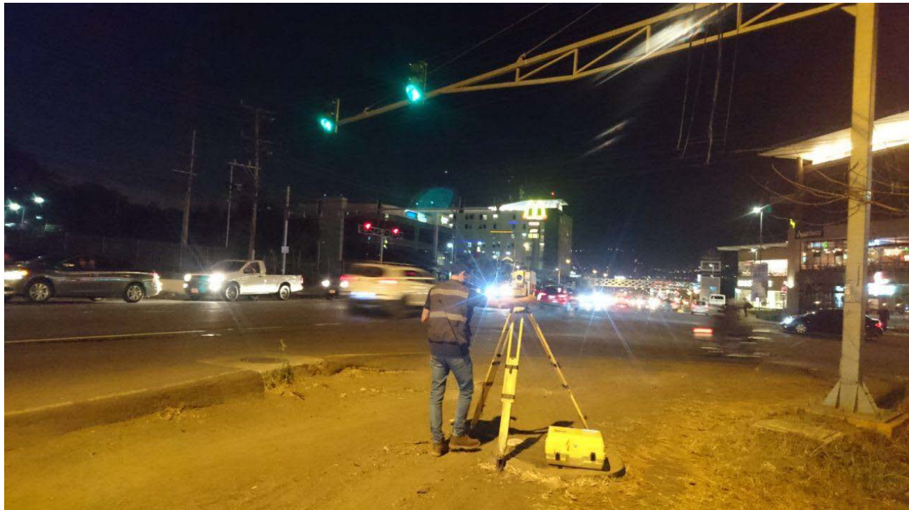
Estación sobre 74C
