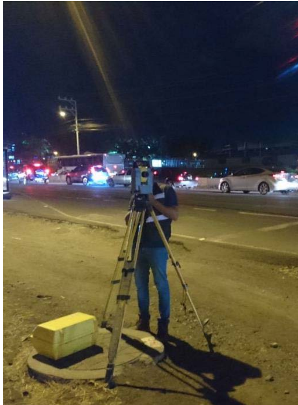
Estación sobre 74C
