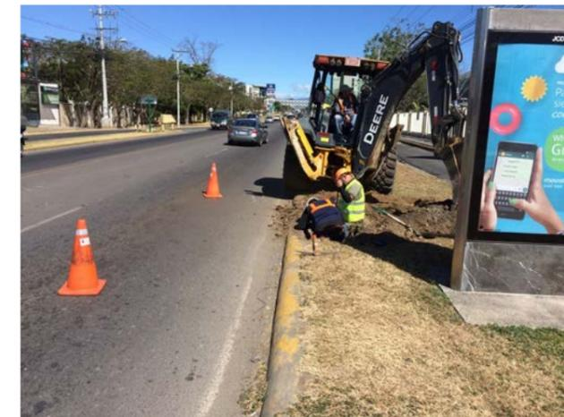
Foto 3-4: Condiciones del sitio durante los trabajos de auscultación del pavimento y retroexcavadora tipo back-hoe utilizada para las excavaciones y muestreo
