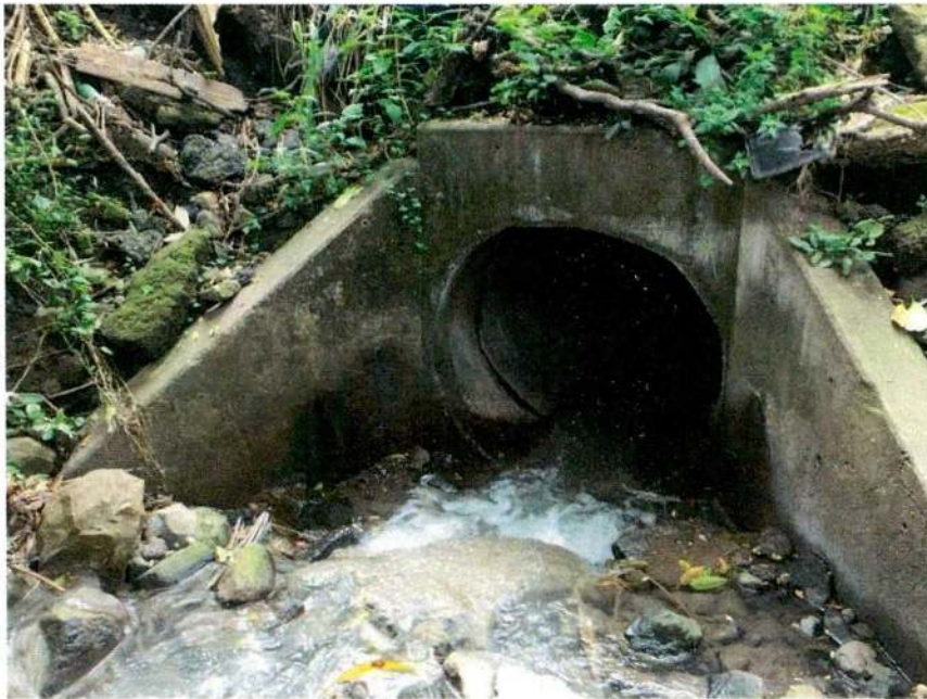
Ilustración 2 Cabezal de salida quebrada Sin Nombre
