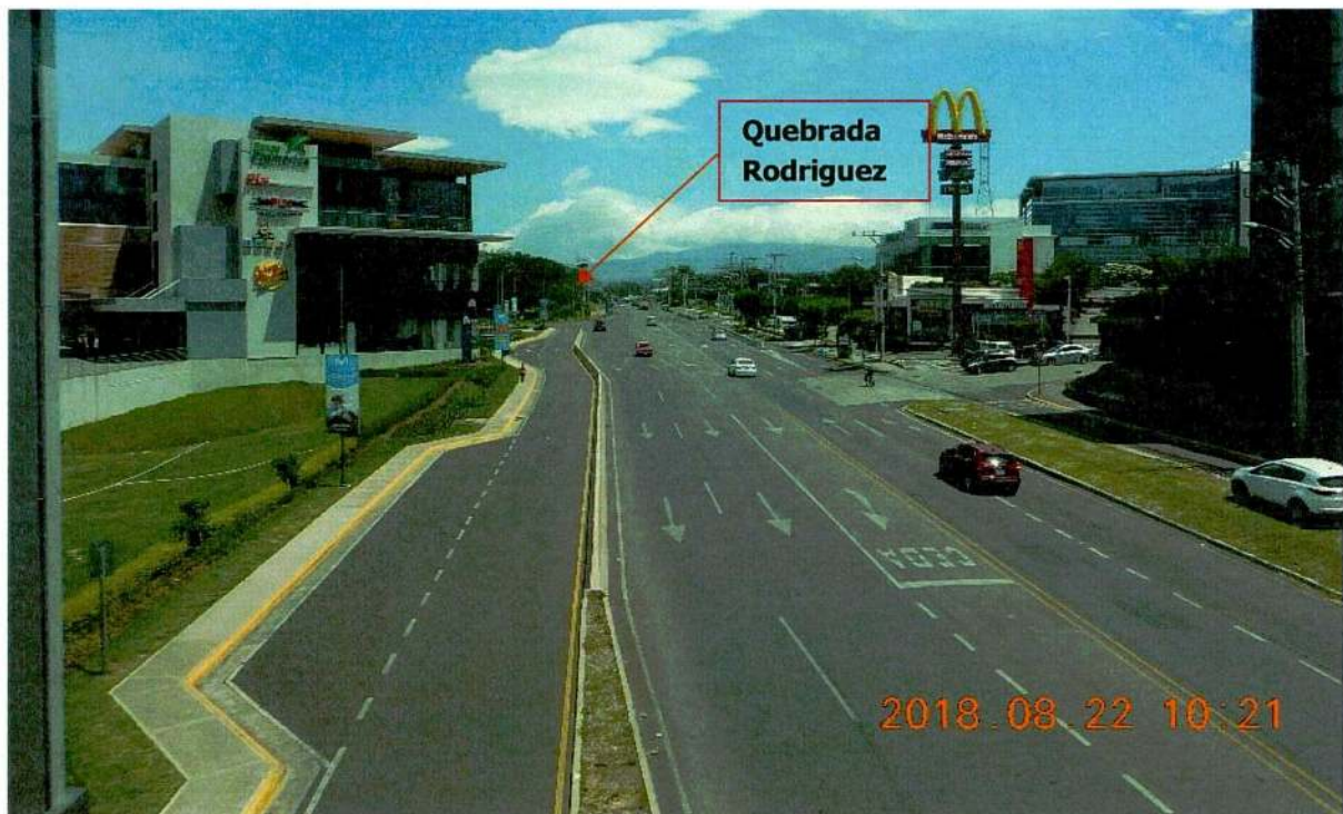
Figura 4. Vista del tramo central del proyecto. Vista desde antes del centro comercial Terrazas de Lindora (478544, 1100933), hacia el norte hasta aproximadamente quebrada Rodriguez. (Fecha:22/08/2018)
