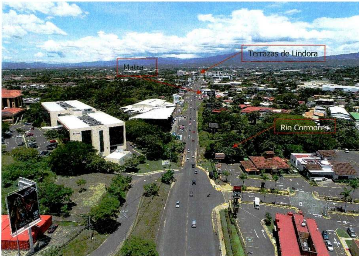
Figura 1. Vista aérea (drone) del trampo inicial del proyecto. Vista de parte sur de la Radial Lindora, desde la intersección con la Ruta Nacional 27 o río Corrogres (479079, 1099639), hacia el norte hasta aproximadamente Matra. (Fecha: 27/09/2018)
