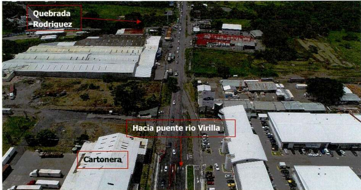
Figura 3. Vista aerea (drone) del tramo final del proyecto. Vista desde Cartonera (antes de puente sobre el río Virilla) (478226, 1101814), hacia el sur hasta aproximadamente quebrada Rodriguez. (Fecha: 10/08/2018)
