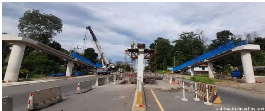
Fotografía 2.12. Construcción de puente peatonal en Matina. Fuente: Crhoy.com.
