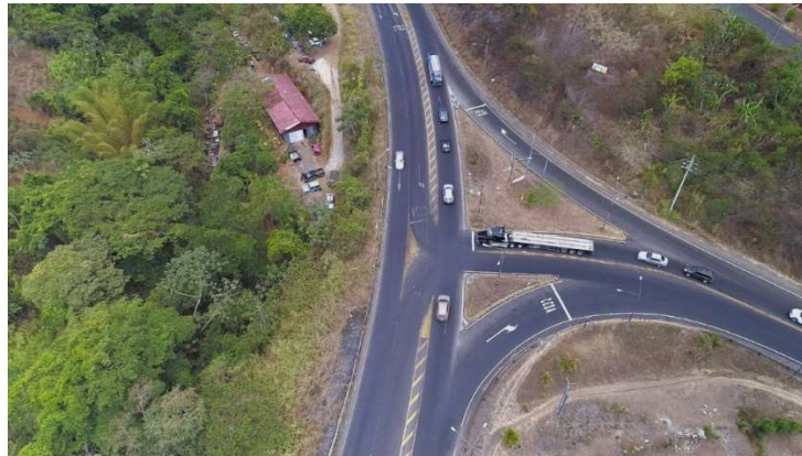
Fotografía 2.9. Vista del intercambio ruta 1 – Naranjo, desvío hacia Sarchí.
