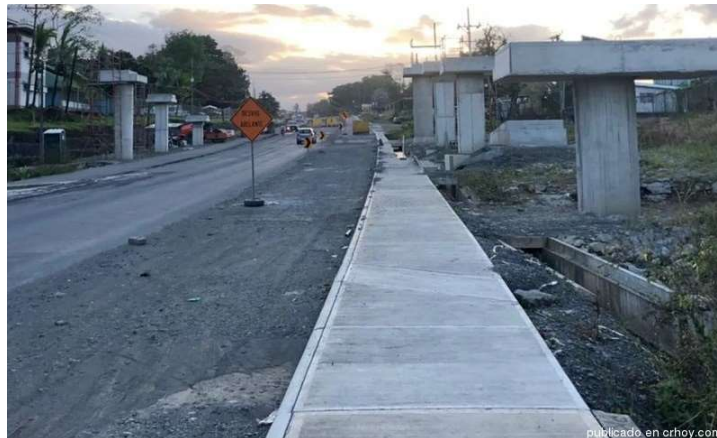
Fotografía 2.13. Construcción de puentes peatonales en Ruta 32.
