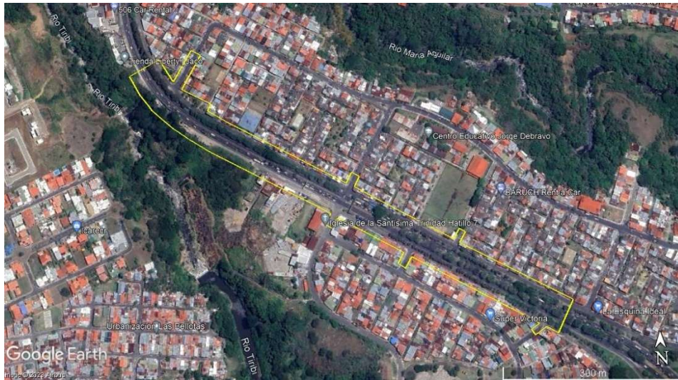
Figura 2.4. Proyecto paso elevado vehicular, accesos y puente peatonal Hatillo 7 y 8. Fuente: Google Earth.
