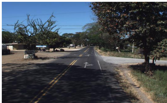
Sector La Irma – Colorado. 2015 Fotografía N° 2
