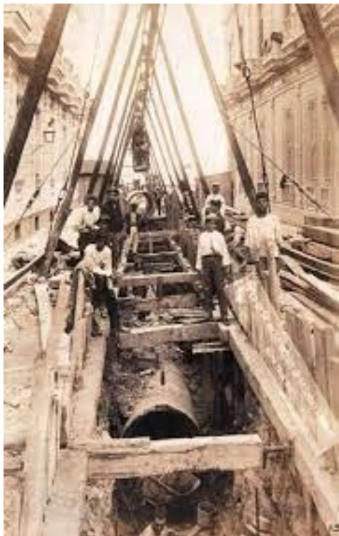
Fig. 8 Ejecución de las obras a principio del siglo XX
