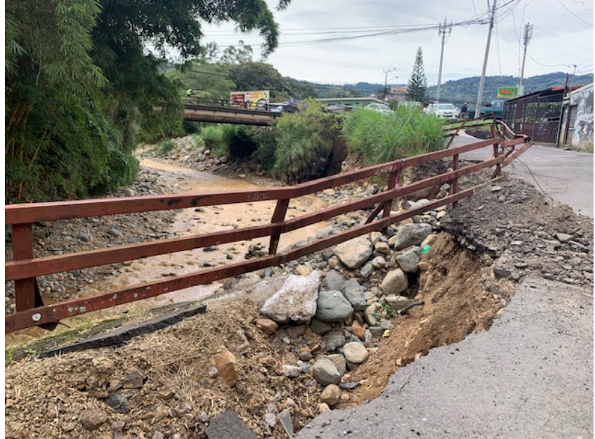
Figura 22. Fotografía del estado del entorno ambiental y social del puente sobre el río Cañas, Desamparados, San José (fotografía tomada por el equipo consultor en visita de campo, 3/11/2022)
