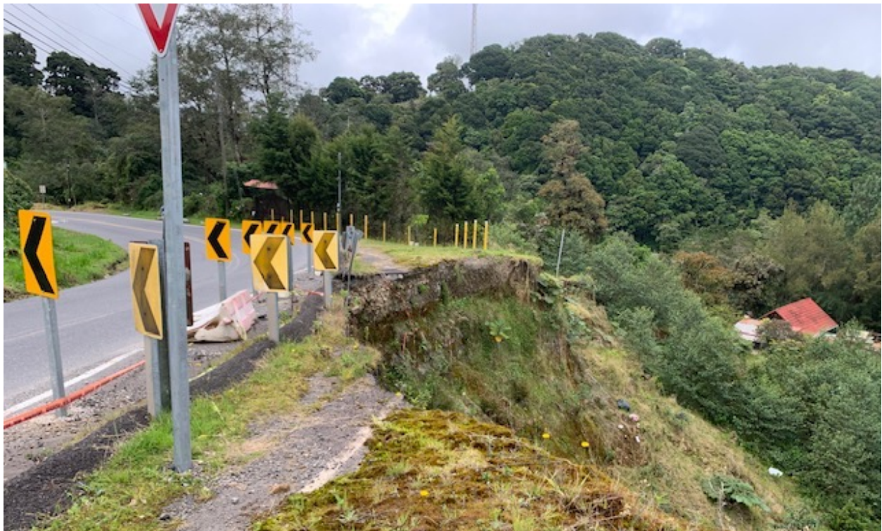
Figura 52. Deslizamiento en el km 51 de la Ruta 2 que requiere de estabilización. (Fotografía tomada por el equipo consultor el 2 de noviembre del 2022)
