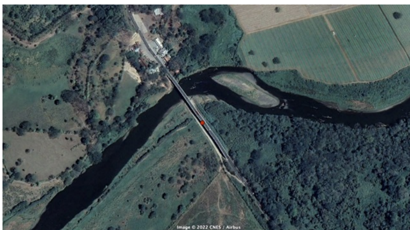
Figura 14. Imagen satelital del puente sobre el río Tárcoles, Punaterenas
