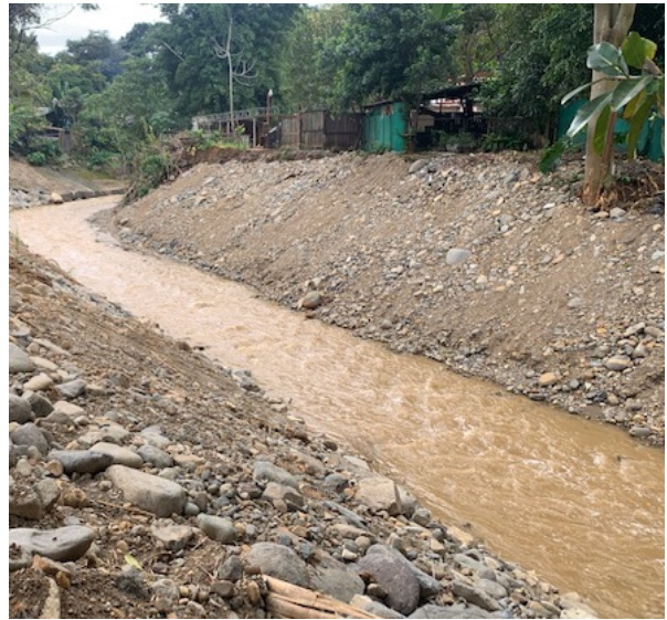
Figura 62. Acción de intervención de la CNE (dragado y estabilización de márgenes del río Cañas
