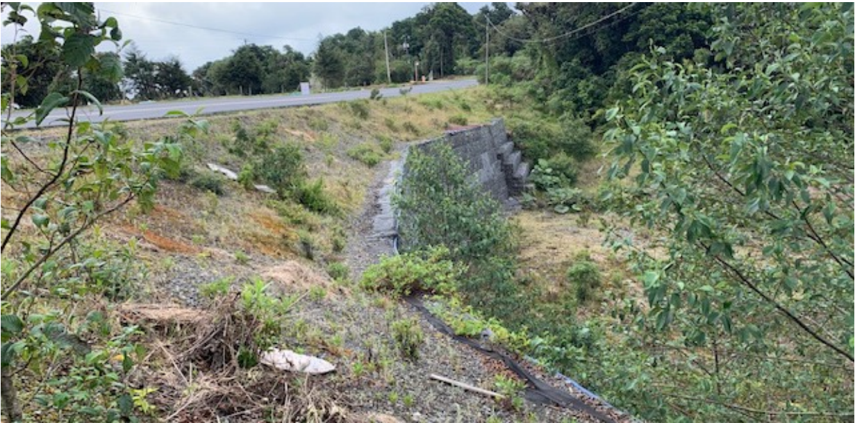
Figura 65. Fotografía de obra implementada en la Ruta 2 para contener un deslizamiento (fotografía tomada en visita de campo el día 1 de noviembre del 2022)
