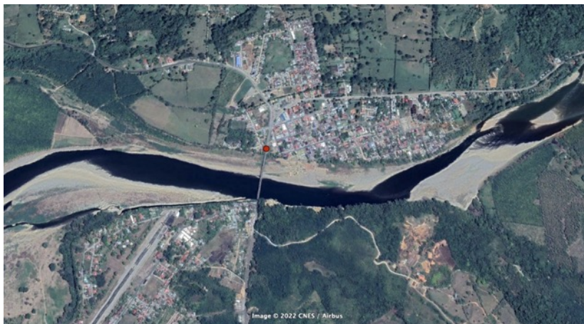
Figura 13. Imagen satelital del puente sobre el río Grande de Térraba, Osa. Aspectos de mayor relevancia, socioeconómico e impacto vial.
