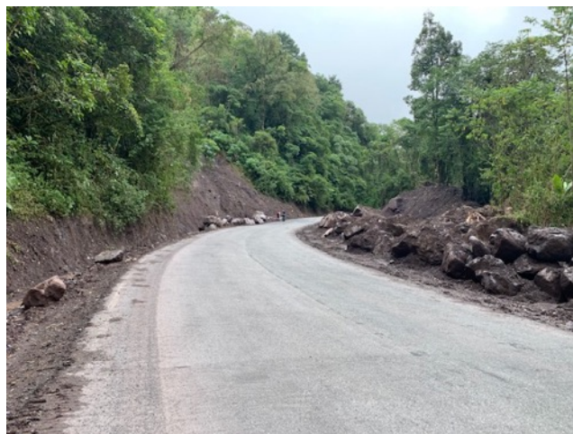
Figura 45. Obras de conservación vial CONAVI por el Deslizamiento en el km 105 sobre la Ruta 2. (Fotografía tomada por el equipo consultor el 1 de noviembre del 2022)
