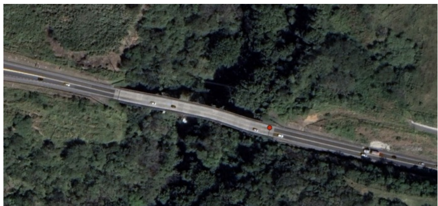
Figura 19. Imagen satelital del puente sobre el río Ciruelas en La Guácima de Alajuela
