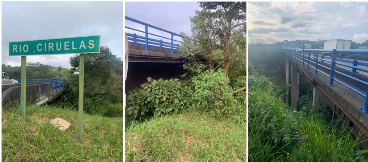
Figura 20. Fotografías del estado del entorno ambiental y social del puente sobre el río Ciruelas, Alajuela (fotografía tomadas por el equipo consultor en visita de campo, 2/11/2022)
