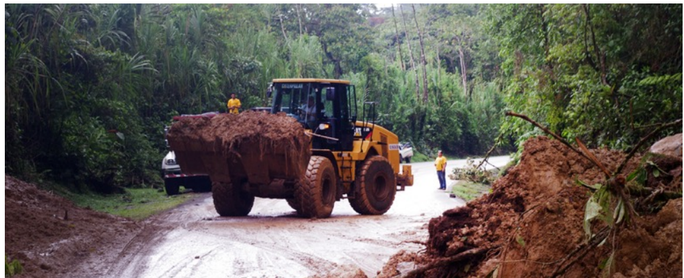
Figura 63. Maquinaria trabajando en atención a deslizamientos en la Ruta 32, en sector Parque Nacional Braulio Carrillo (fotografía tomada de la Web del MOPT, 2019)
