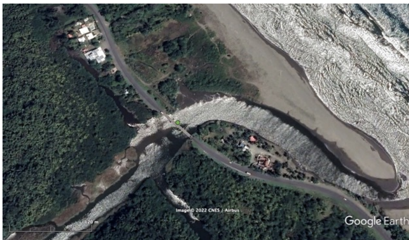
Figura 37. Puente sobre la quebrada Vizcaya, Limón
