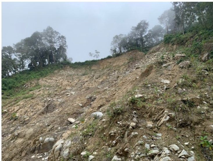
Figura 41. Deslizamiento en el km 102 sobre la Ruta 2. (Fotografía tomada por el equipo consultor el 1 de noviembre del 2022)
