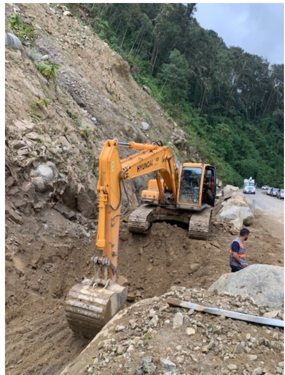
Figura 61. Maquinaria trabajando en atención de deslizamientos en Ruta 2
