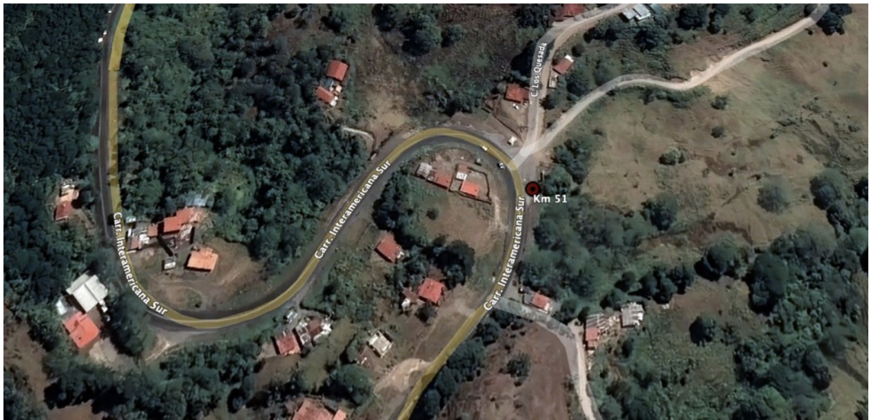
Figura 52. Deslizamiento en el km 51 de la Ruta 2.
