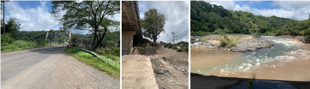
Figura 11. Fotografías del estado del entorno ambiental y social del puente sobre el río Barranca, Puntarenas (fotografía tomadas por el equipo consultor en visita de campo, 2/11/2022)
