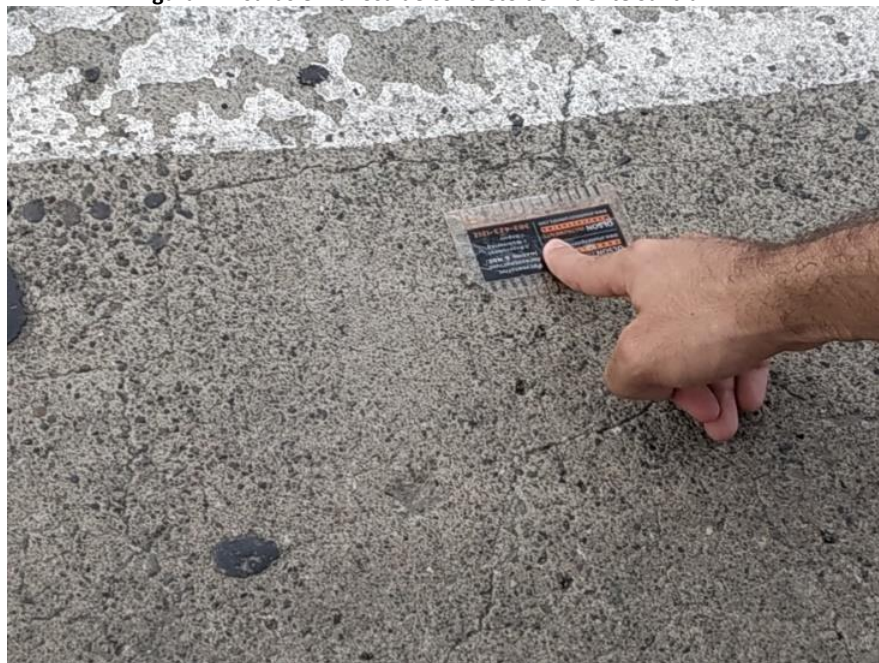
Figura 2. Fisuras en la losa de concreto del Puente Salitral
