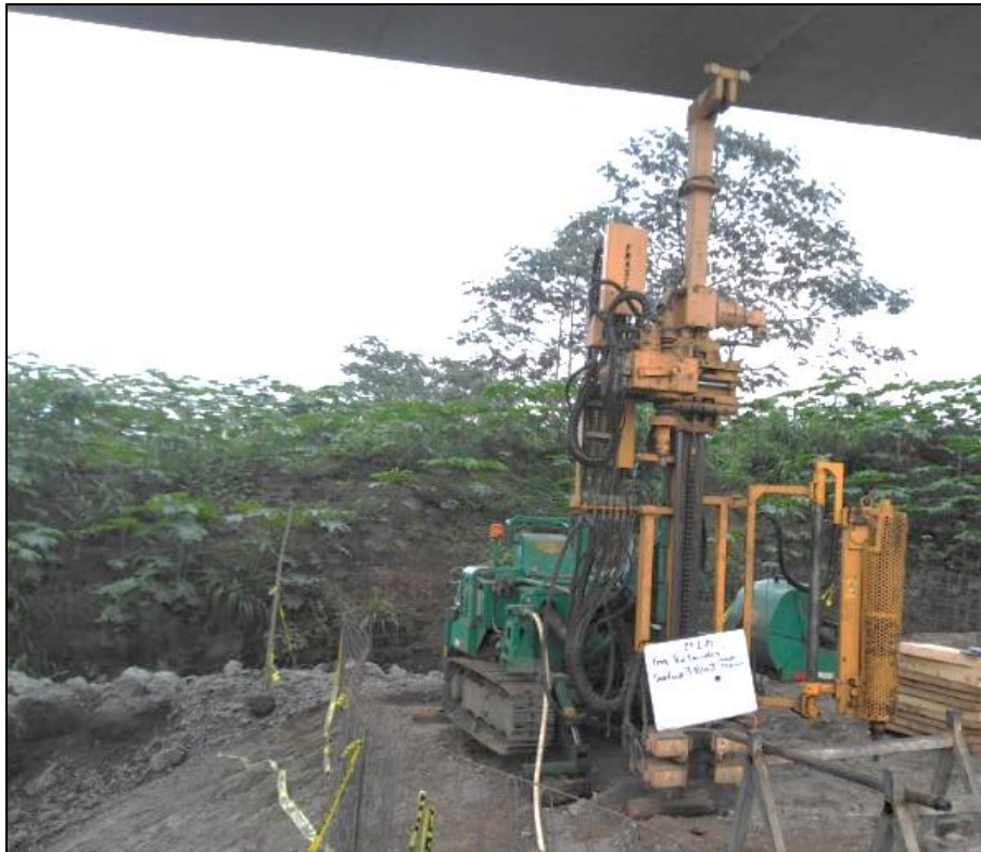
Fotografía 16. Zona de perforación sondeo S-3 Pila 2 (MI) - Método de rotación.
