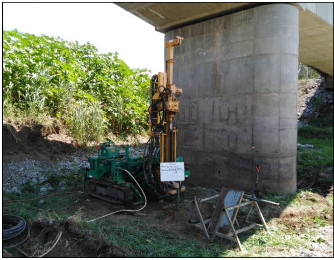
Fotografía 9. Zona de perforación sondeo S-2 Pila 1 (MI) - Método de rotación.
