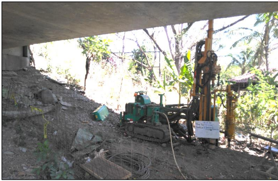
Fotografía 37. Zona de perforación sondeo S-6 Bastión 2 (MD) - Método de rotación.
