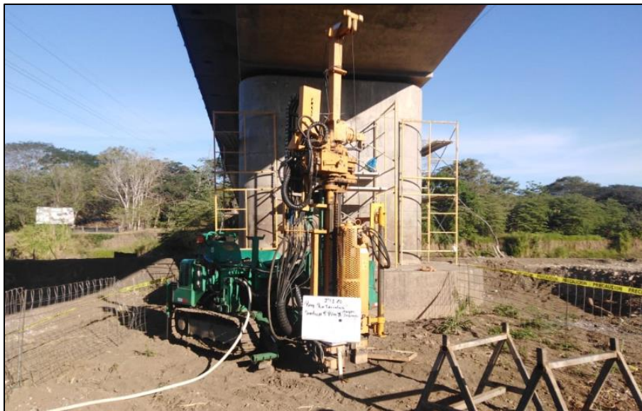
Fotografía 24. Zona de perforación sondeo S-4 Pila 3 (MI) - Método de rotación.
