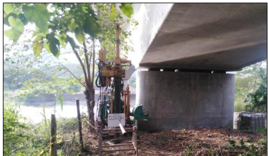
Fotografía 32. Zona de perforación sondeo S-5 Pila 4 (MD) - Método de rotación.
