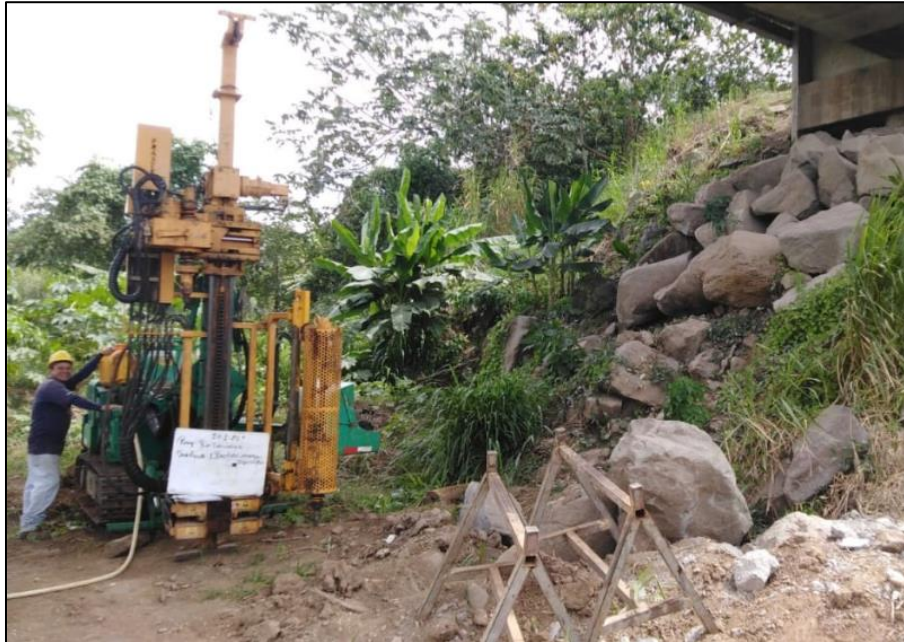
Fotografía 2. Zona de perforación sondeo S-1 Bastión 1 (MI) - Método de rotación.
