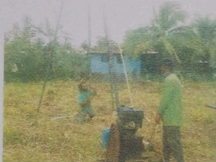
Figura 2: Ejecución del sondeo P-2
