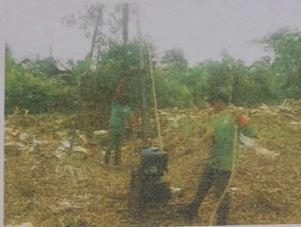
Figura 4: Ejecución del sondeo P-4
