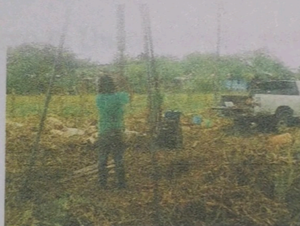
Figura 5: Ejecución del sondeo P-5
