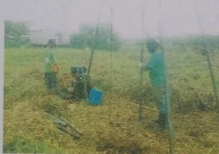
Figura 3: Ejecución del sondeo P-3
