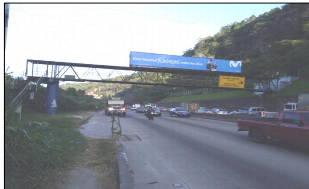
Ilustración 77: Pasarela existente en estación 16+990
