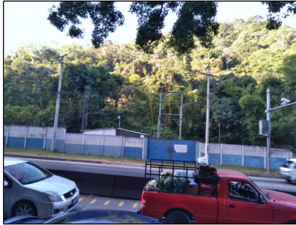
Ilustración 81: Ubicación Planta de Bombeo ANDA, tramo 1
