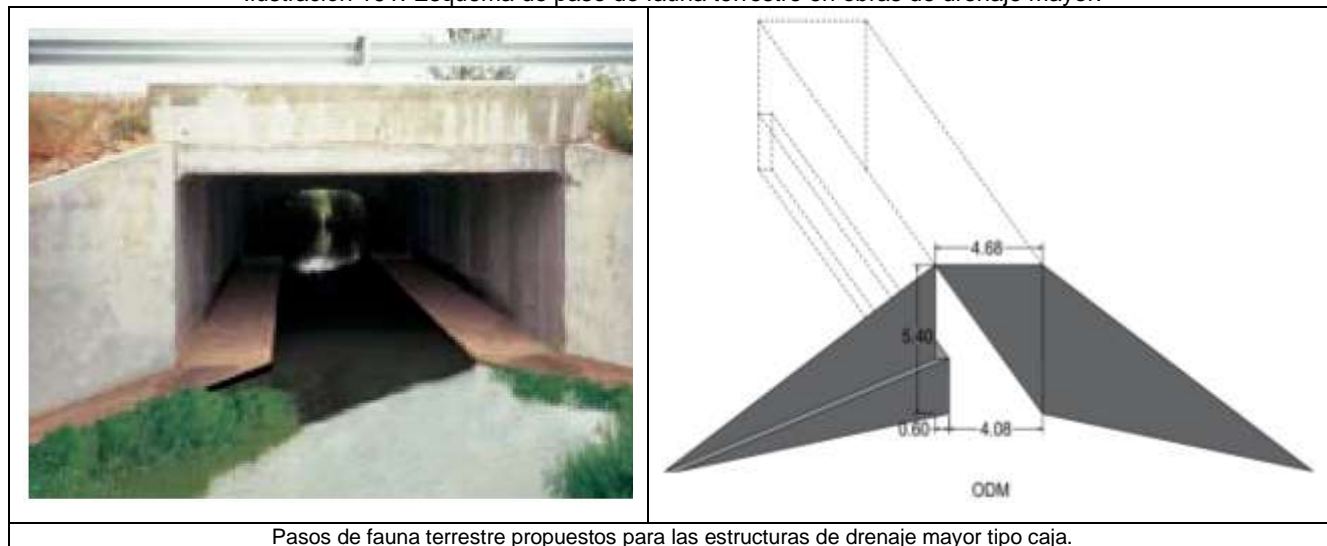
Pasos de fauna terrestre propuestos para las estructuras de drenaje mayor tipo caja.
