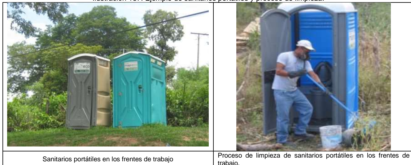
Ilustración 187. Ejemplo de sanitarios portátiles y proceso de limpieza.
