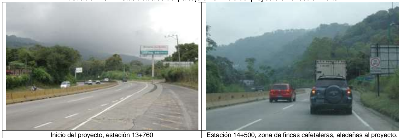
Ilustración 167. Vistas actuales del paisaje en el inicio del proyecto en dirección norte.
