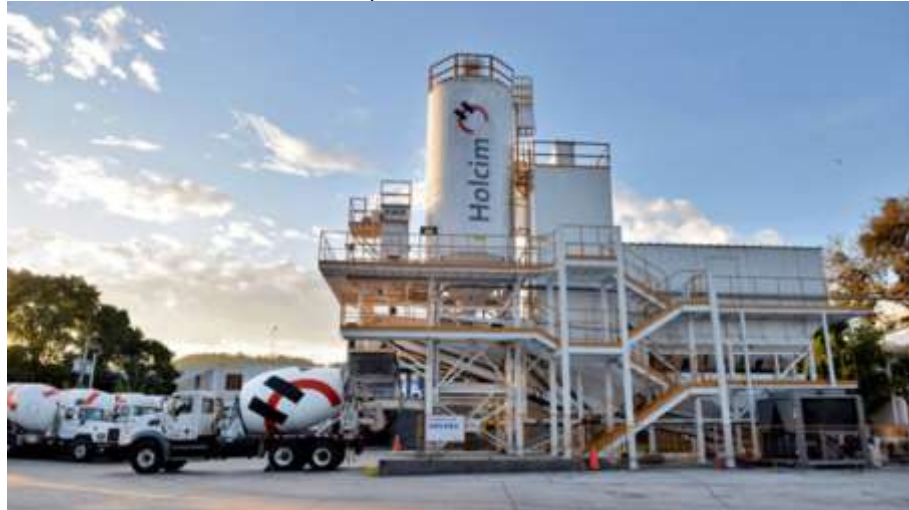
Ilustración 58. Instalaciones de la planta dosificadora de concreto hidráulico Holcim.
