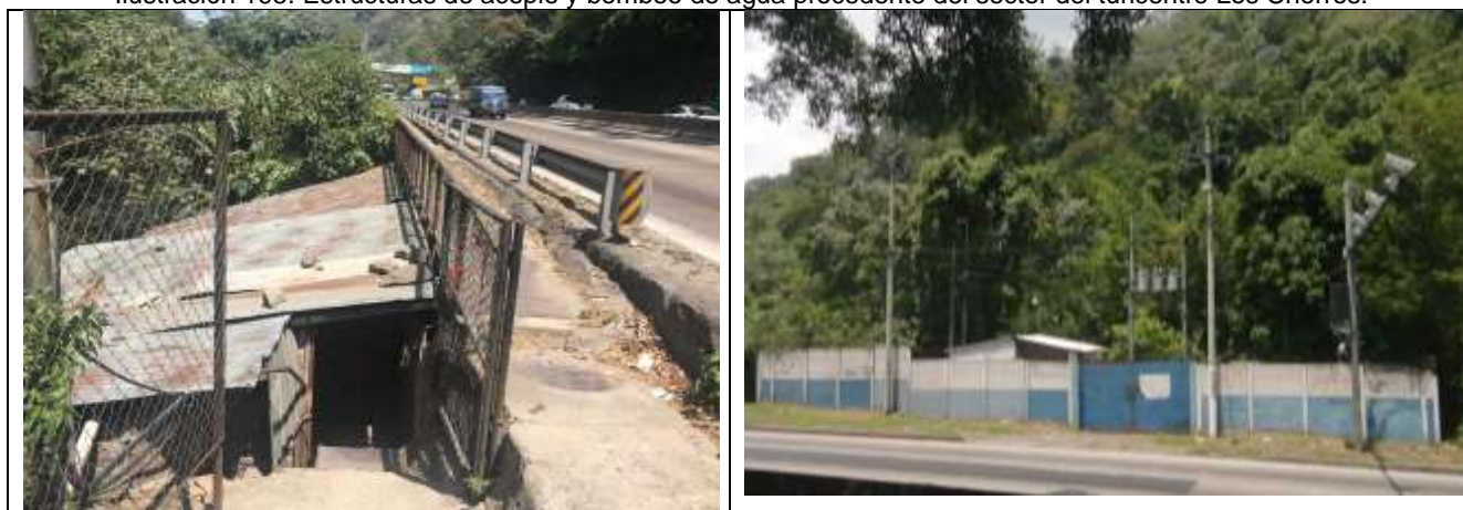
Estructuras de acopio de agua que escurre del turicentro Los Chorros y atraviesa la zona pavimentada al lateral izquierdo de la actual vía. A la derecha se ubica la planta de acopio y bombeo del ANDA.
