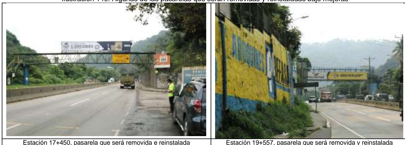
Estación 17+450, pasarela que será removida e reinstalada
