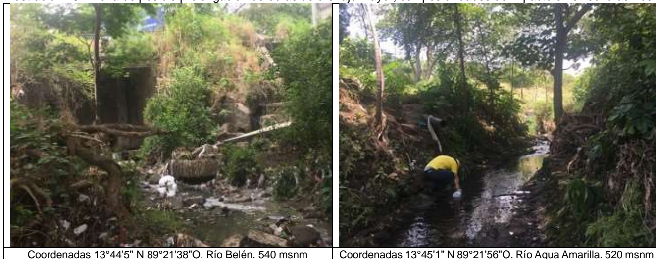
Ilustración 161. Zona de posible prolongación de obras de drenaje mayor, con posibilidades de impacto en el lecho de ríos.
