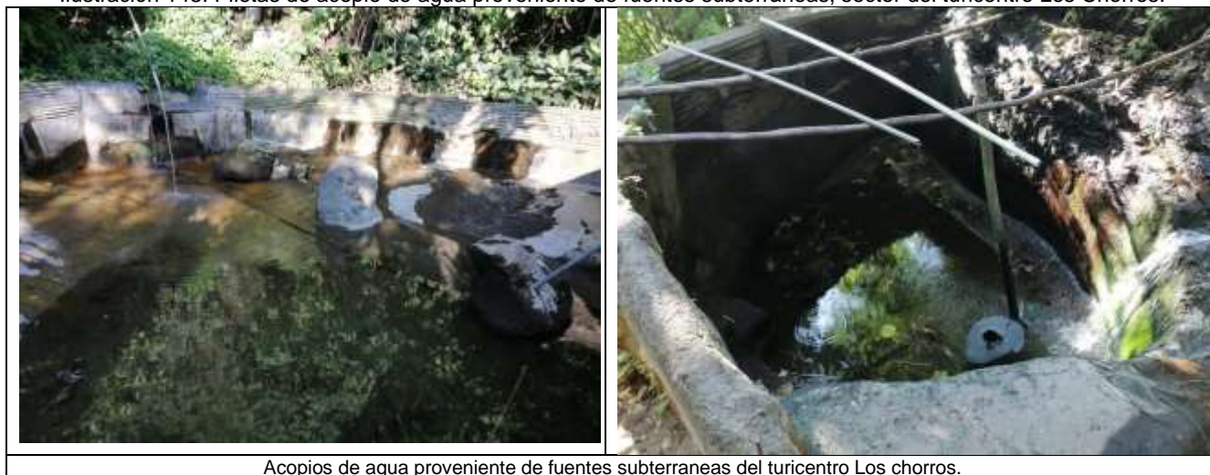
Ilustración 143. Piletas de acopio de agua proveniente de fuentes subterráneas, sector del turicentro Los Chorros.
