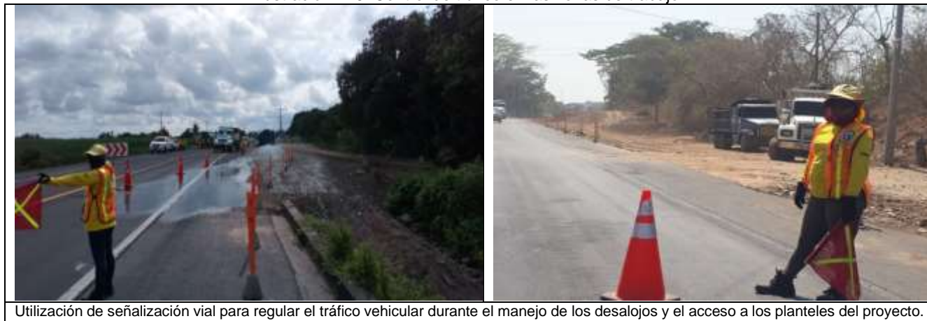
Ilustración 176. Control de tráfico en las zonas de trabajo.
