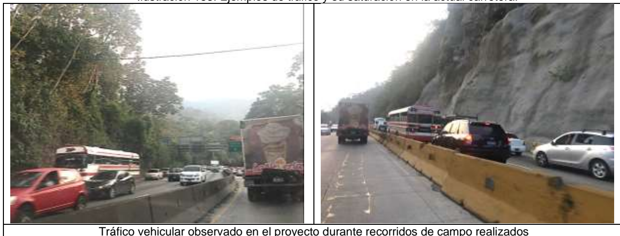
Ilustración 153. Ejemplos de tráfico y su saturación en la actual carretera.
