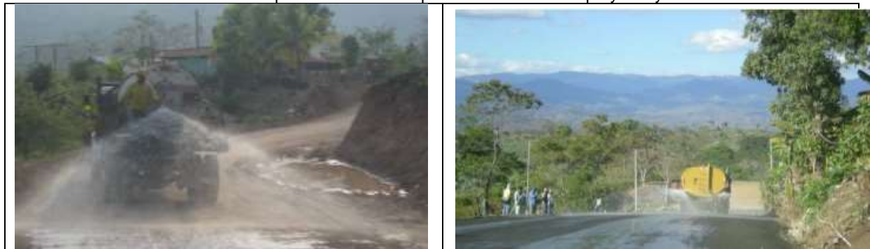
Ilustración 183. Pipas con rociadores para humectación del proyecto y zonas aledañas.
