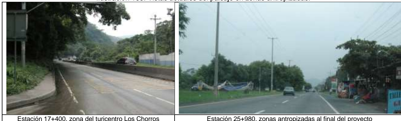
Estación 17+400, zona del turicentro Los Chorros
