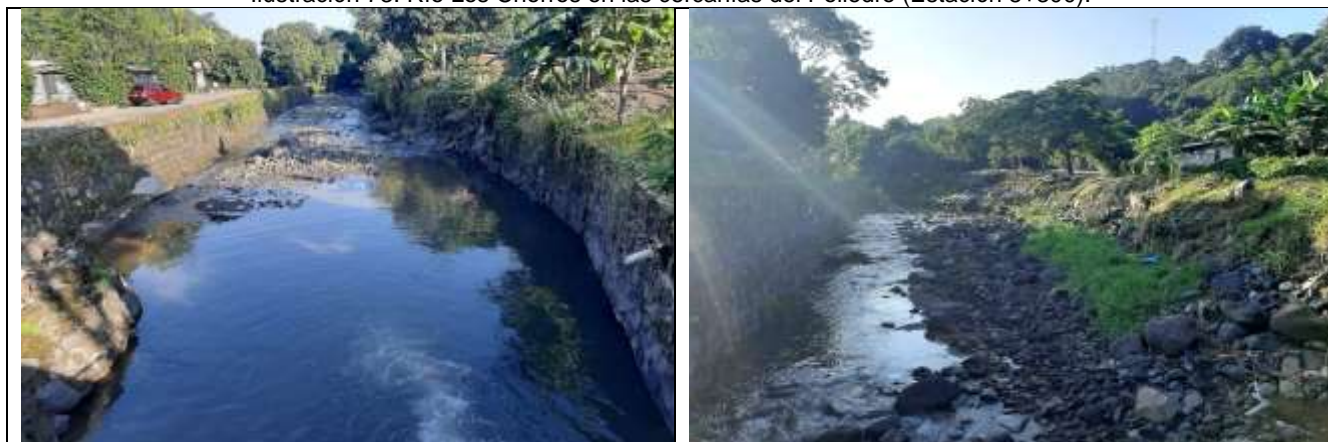
Ilustración 73. Río Los Chorros en las cercanías del Poliedro (Estación 8+300).
