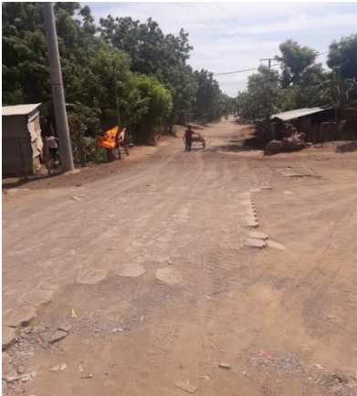
Foto 6. 7 Red de energía eléctrica con medidores.
