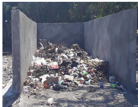
Foto 3. 5 Estación de transferencia localizada a orillas del Lago Xolotlán
