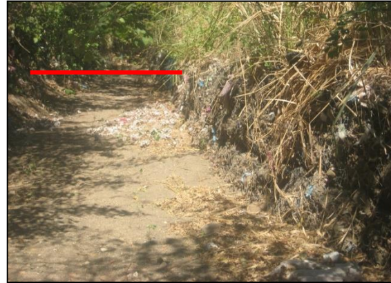
Foto 44: Llanura de inundación, cauce del río Obraje aguas arriba punto de vertido de la PTAR El Patriarca
