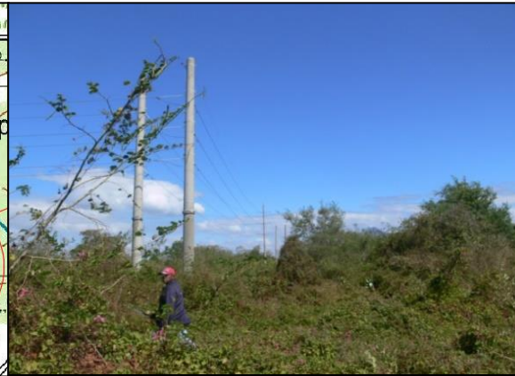
Foto 41: Líneas de alta tensión cercana al predio propuesto. Fuente Esp. Ambiental
