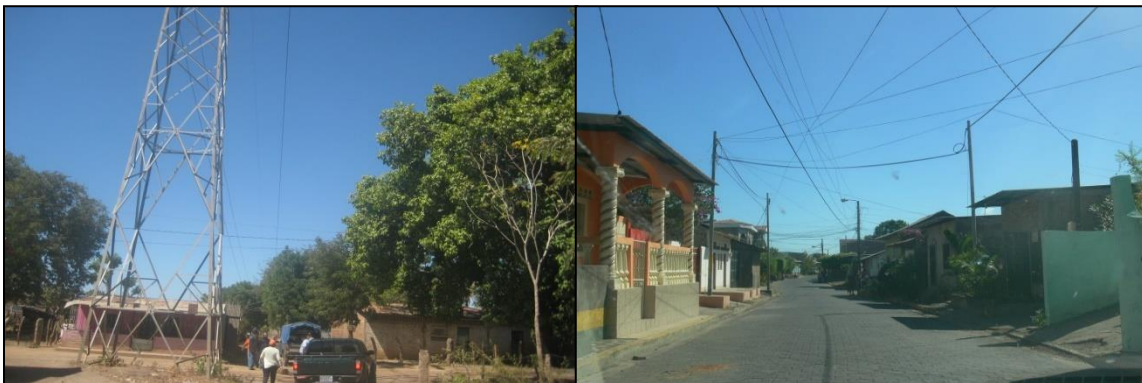
Foto 27: Izq. áreas de viviendas cercana y debajo de estructuras y líneas de alta tensión Dcha. tendido eléctrico domiciliario en la ciudad de Nagarote
