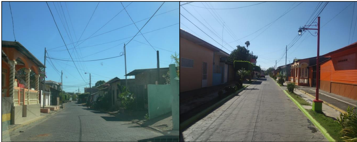
Foto 1: Características de equipamiento urbano, calle urbana con revestimiento, tendido eléctrico de media tensión, telefonía, alumbrado público, área central Nagarote
