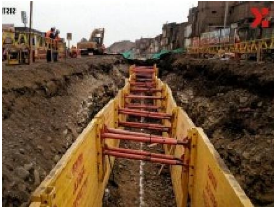
Imagen 24: Para excavaciones en zanjas que tendrán un tiempo de ejecución mayor de un día o que el tipo de suelo y profundidad lo amerite, se llevará a cabo el apuntalamiento de las paredes.
