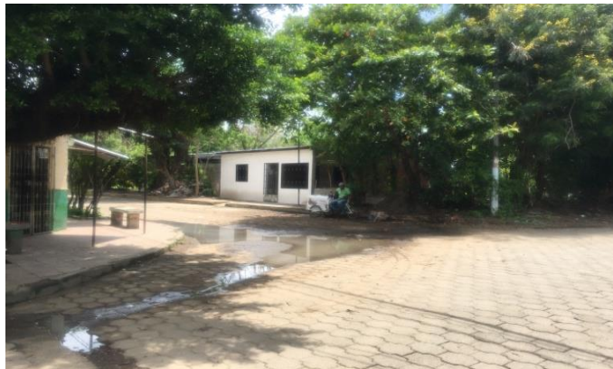
Imagen 14: Aguas residuales en calle Bo. San Martin
