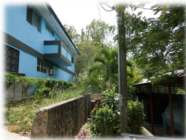
Figura 2.4. Sitio de ampliación de PTAP
