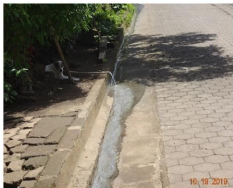
Aguas grises dispuesta en cunetas
