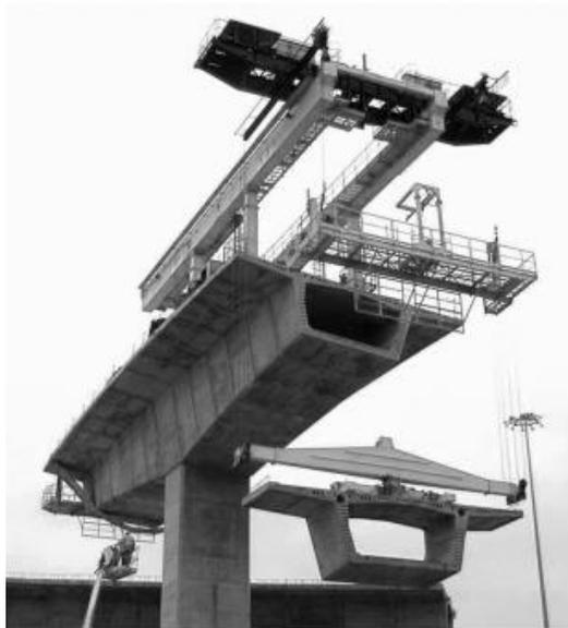
*Ilustración 6. Avance progresivo en un puente de voladizos sucesivos con secciones prefabricadas en donde se observa la sección transversal de tipo cajón*
