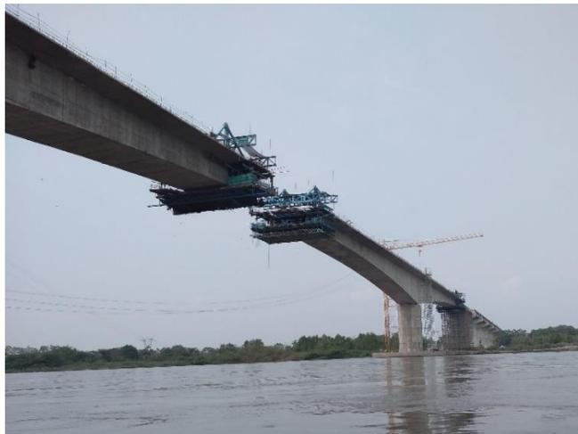
*Ilustración 5. Unión de dos avances progresivos en un puente de voladizos sucesivos.*
