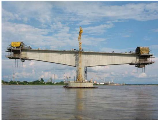
*Ilustración 4. Ejemplo de la construcción de una pilastra y la ejecución sucesiva y equilibrada de la superestructura del puente.*
