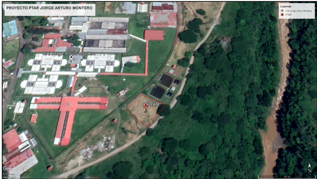
Imagen 12. Emplazamiento de PTAR CAI Jorge Arturo Montero Castro.
