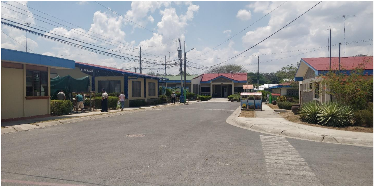
Figura 2. Instalaciones actuales del CAI Calle Real
