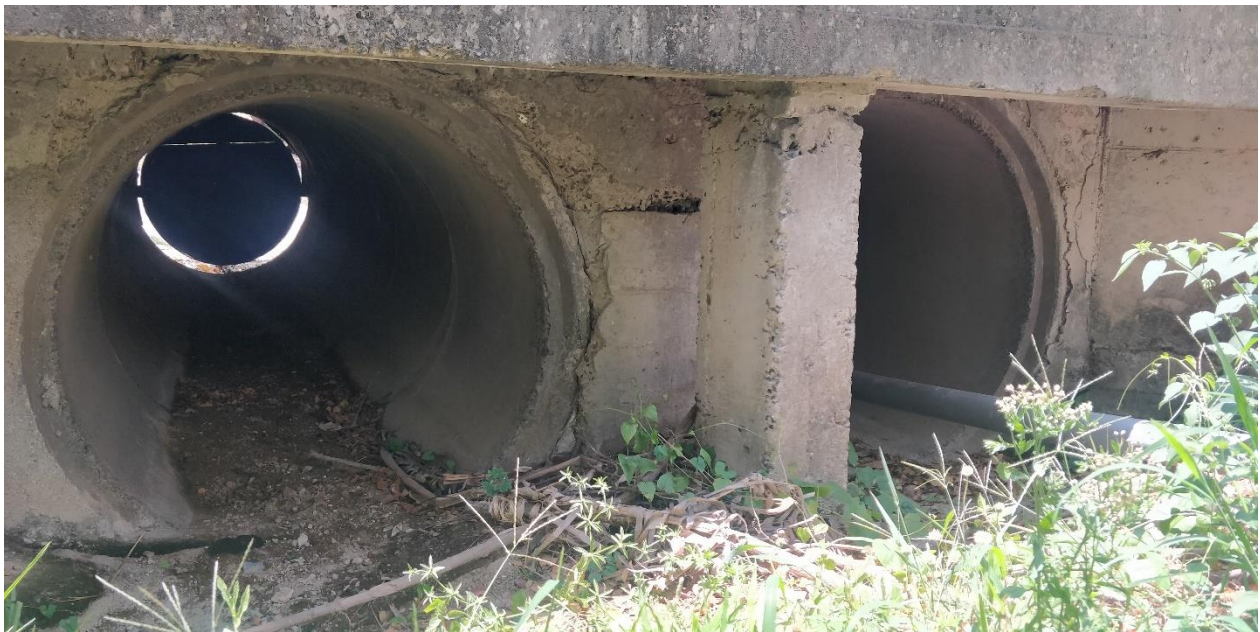
Figura 7. Alcantarillas en punto de control
