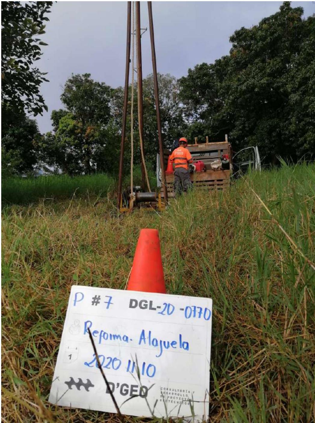
Fotografía #B.7 Fotografías de los sondeos SPT realizados. P-7.
