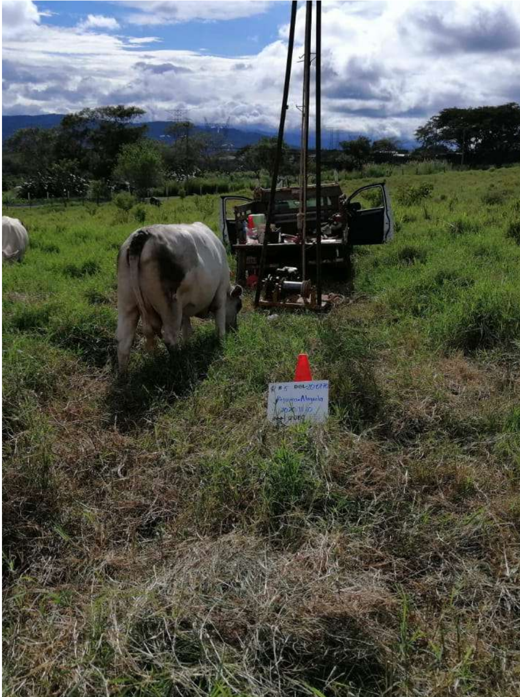
Fotografía #B.5 Fotografías de los sondeos SPT realizados. P-5.
