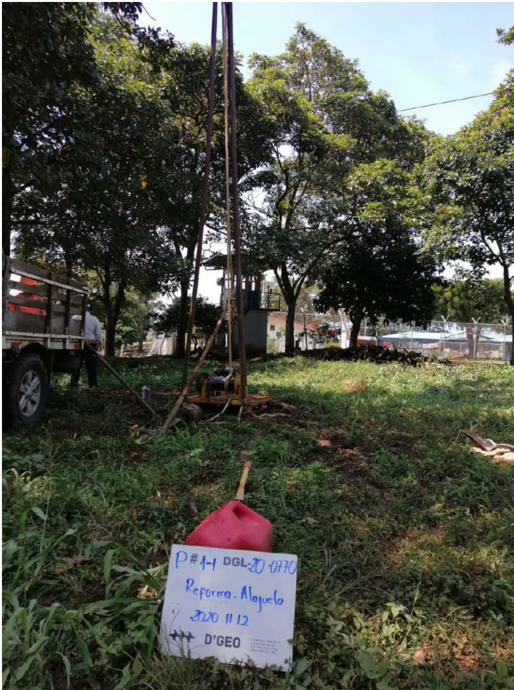
Fotografía #B.12 Fotografías de los sondeos SPT realizados. P-1-1.
