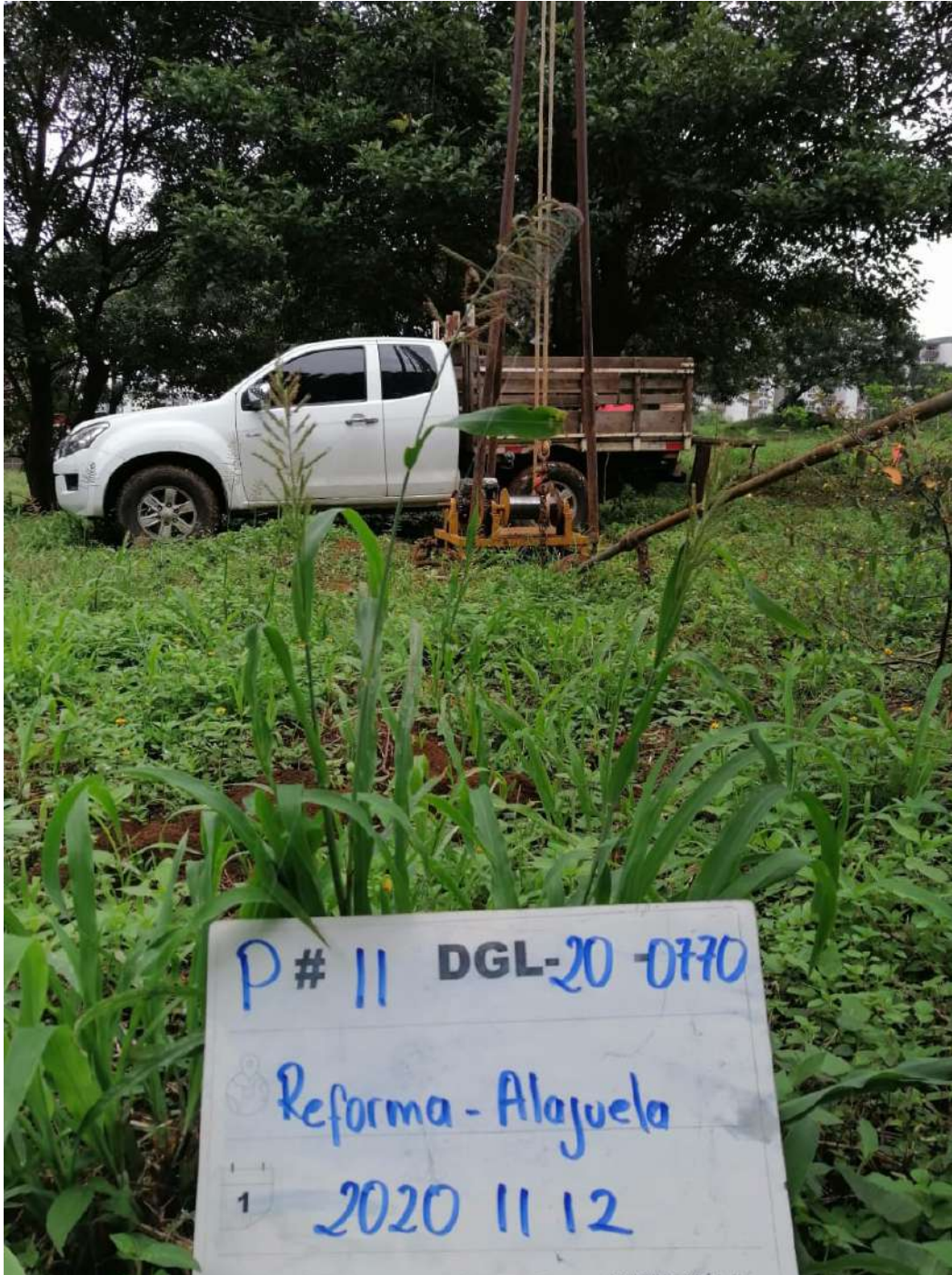
Fotografía #B.11 Fotografías de los sondeos SPT realizados. P-11.
