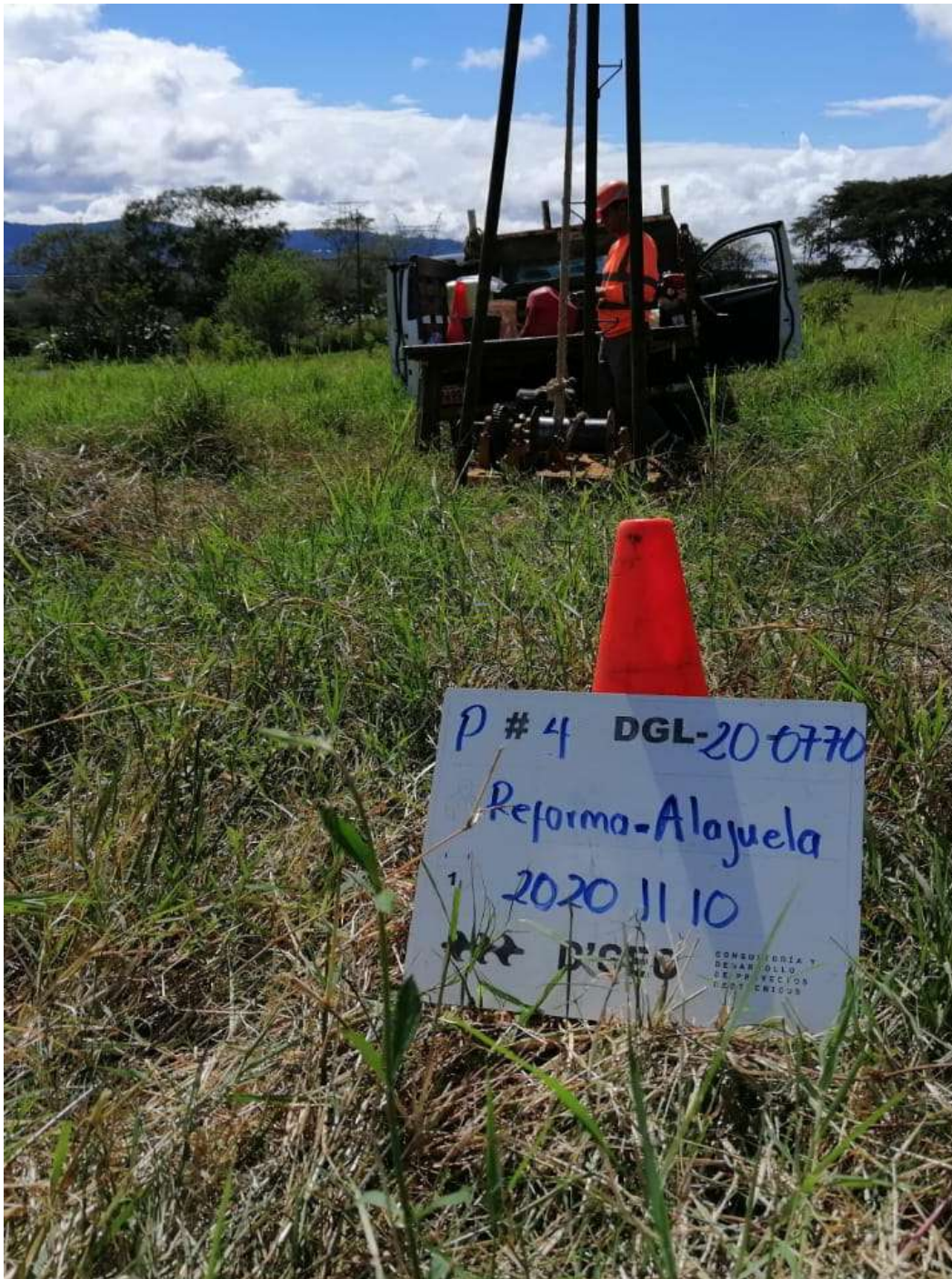
Fotografía #B.4 Fotografías de los sondeos SPT realizados. P-4.
