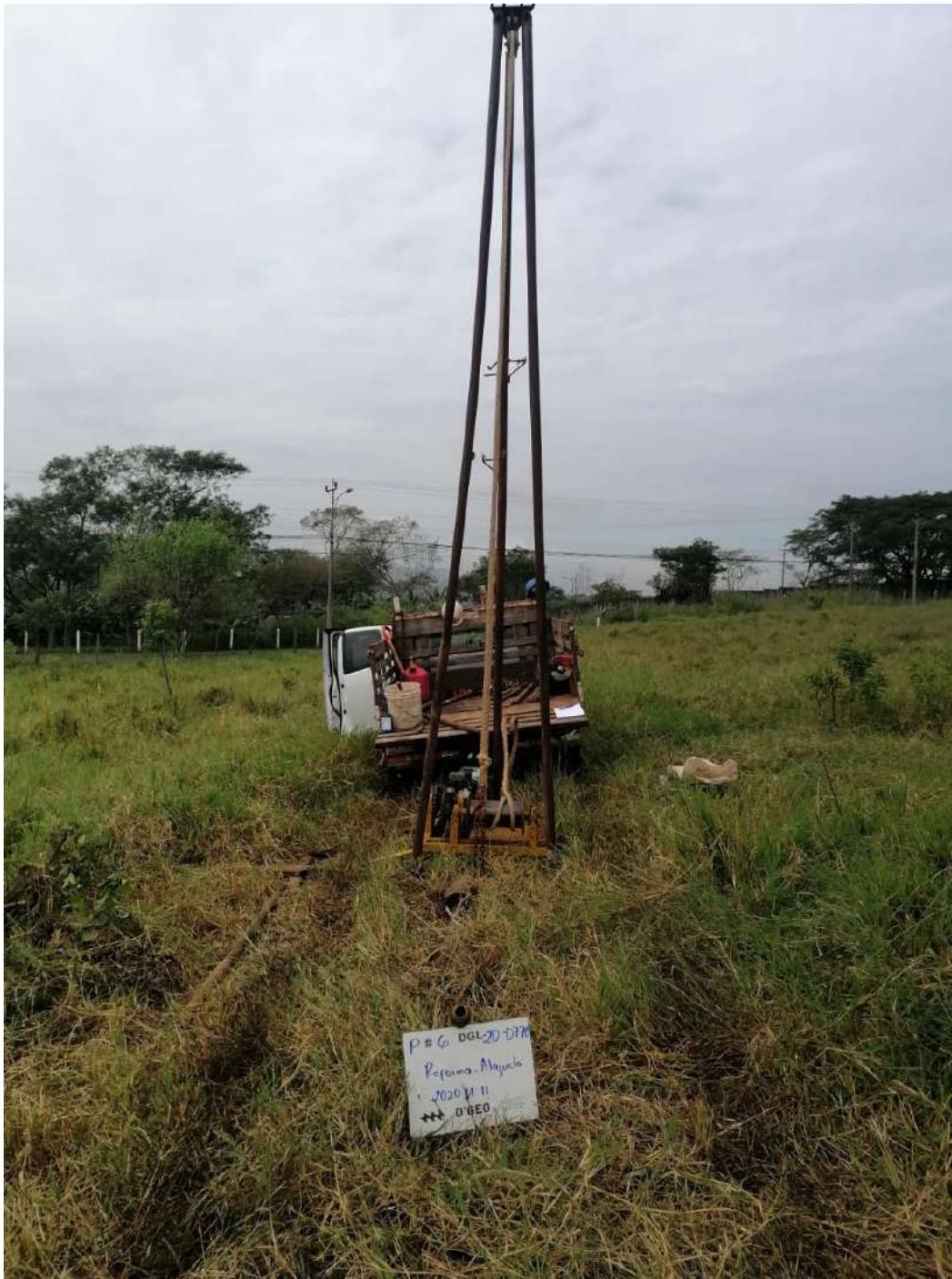
Fotografía #B.6 Fotografías de los sondeos SPT realizados. P-6.
