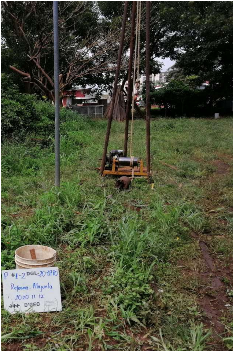
Fotografía #B.13 Fotografías de los sondeos SPT realizados. P-1-2.
