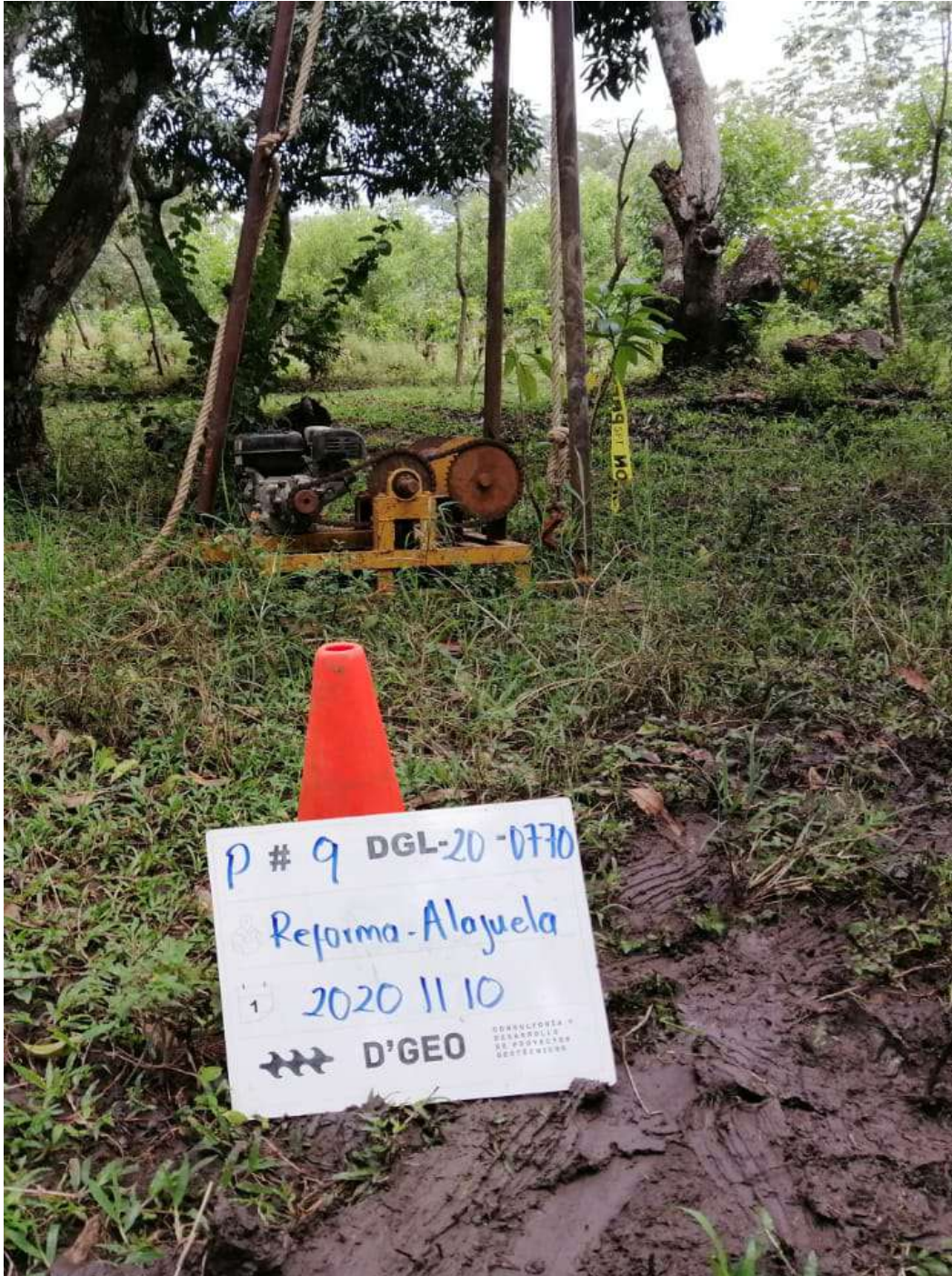
Fotografía #B.9 Fotografías de los sondeos SPT realizados. P-9.
