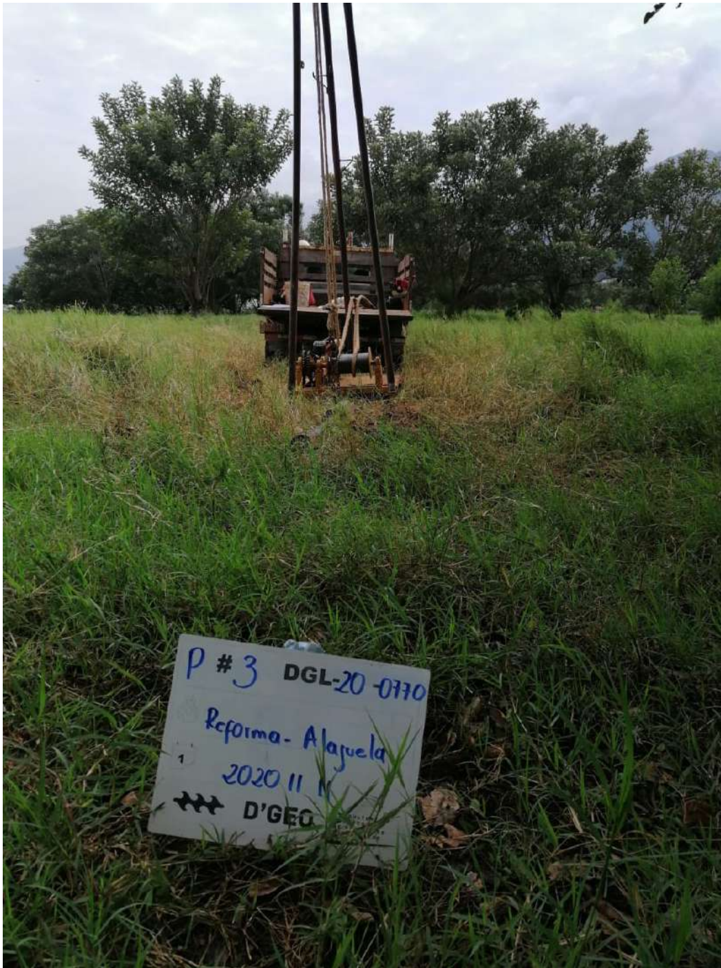
Fotografía #B.3 Fotografías de los sondeos SPT realizados. P-3.
