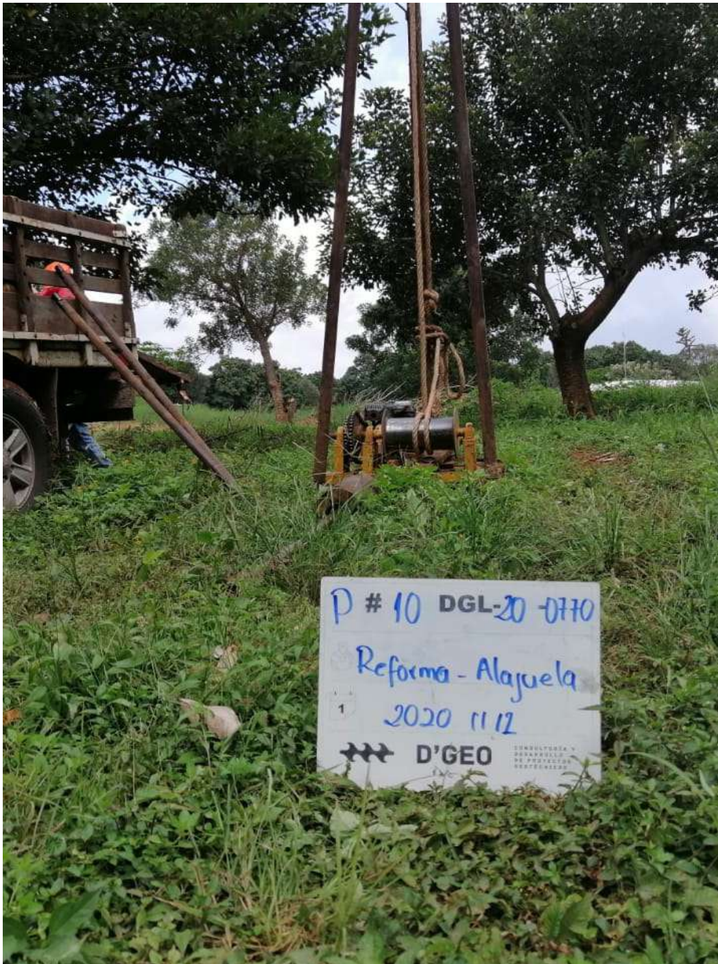
Fotografía #B.10 Fotografías de los sondeos SPT realizados. P-10.
