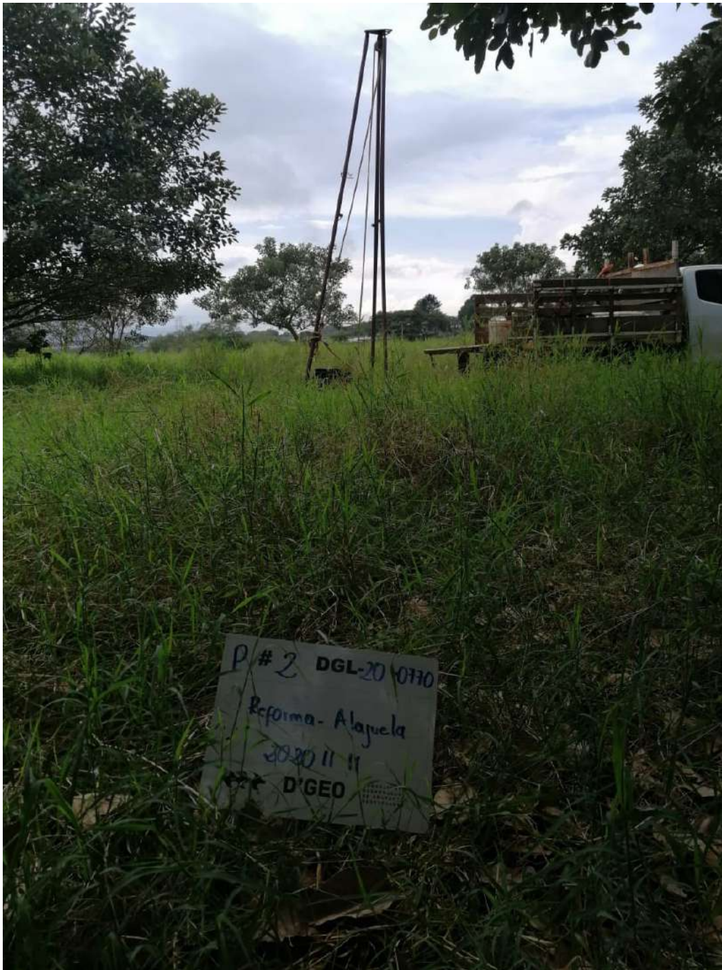
Fotografía #B.2 Fotografías de los sondeos SPT realizados. P-2.
