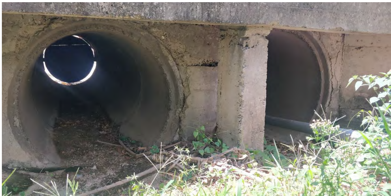
Figura 7. Alcantarillas en punto de control
