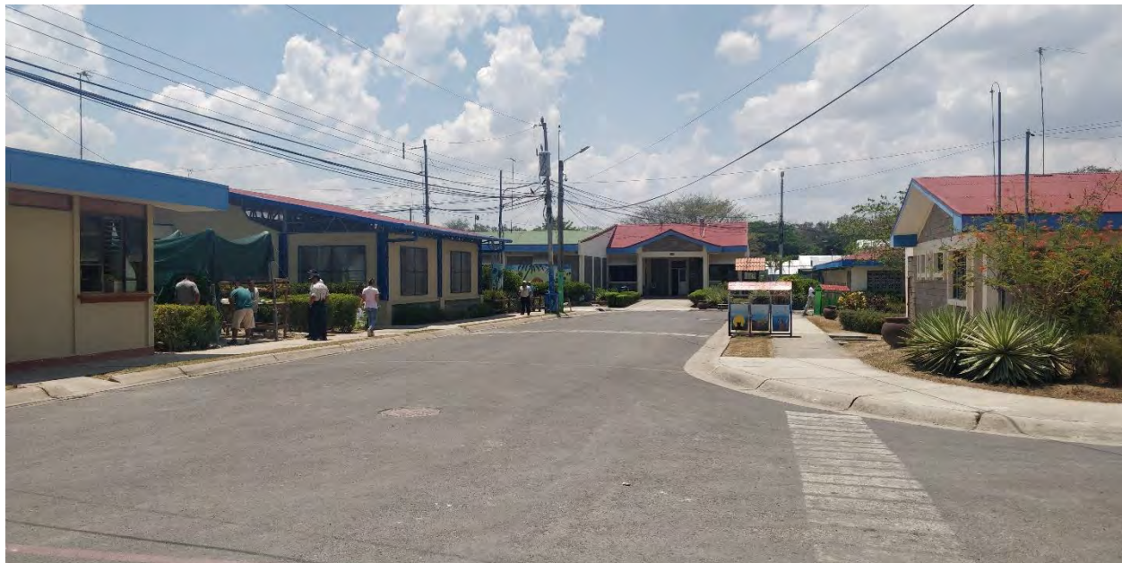
Figura 2. Instalaciones actuales del CAI Calle Real
