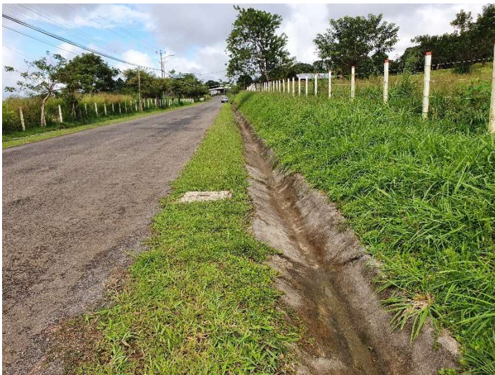
Fotografía 16: Sección Canal Triangular A
