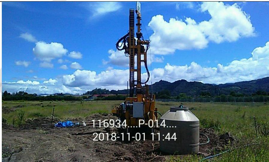
*Proceso de la perforación P-14, equipo de rotación instalado en una zona con vegetación baja, de topografía bastante plana, y sin edificaciones.*
