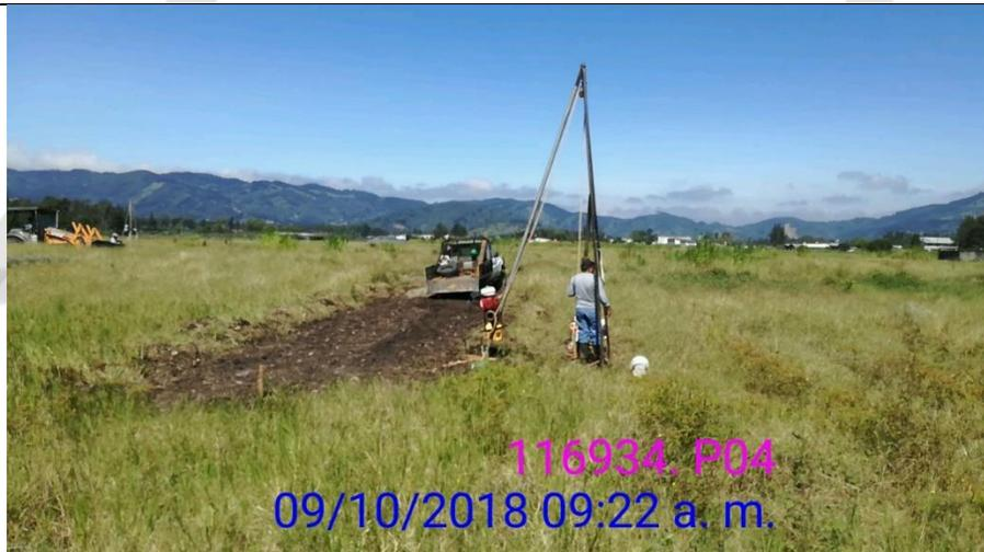
*Proceso de la perforación P-4, realizada en una zona con vegetación baja, de topografía bastante plana, y sin edificaciones.*
