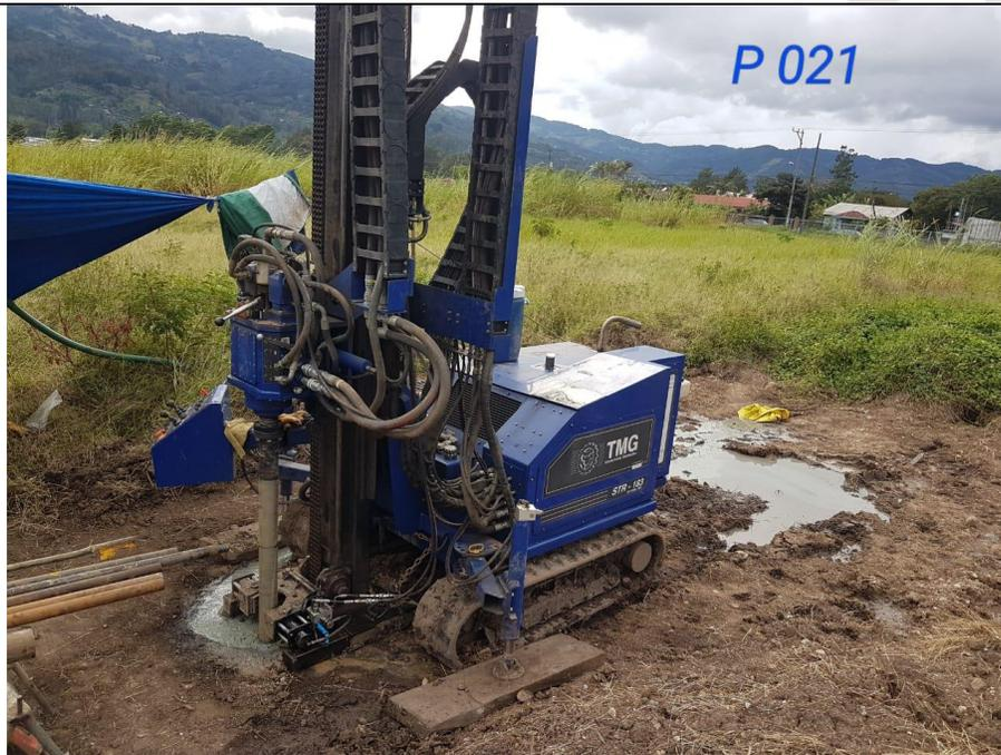
Proceso de la perforación P-21, equipo de rotación instalado en una zona con vegetación baja, de topografía bastante plana, y sin edificaciones.
