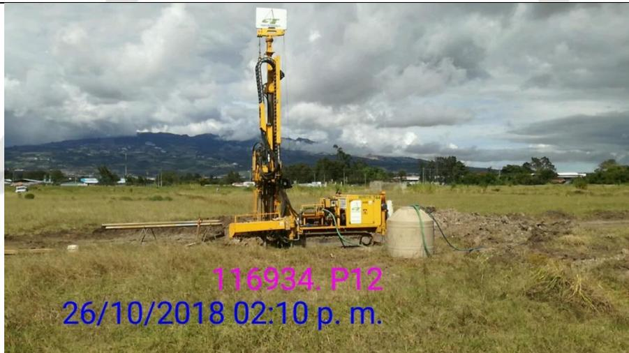
*Proceso de la perforación P-12, equipo de rotación instalado en una zona con vegetación baja, de topografía bastante plana, y sin edificaciones.*
