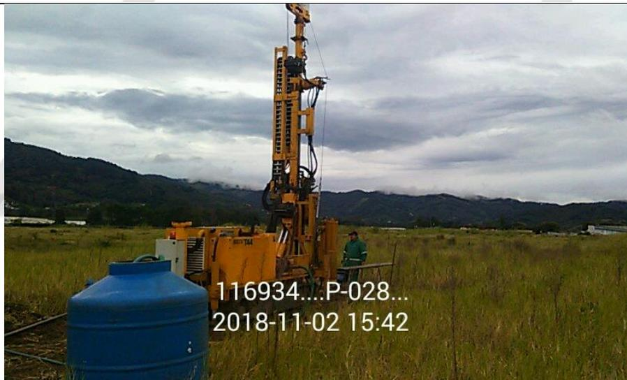
*Proceso de la perforación P-28, equipo de rotación instalado en una zona con vegetación baja, de topografía bastante plana, y sin edificaciones.*
