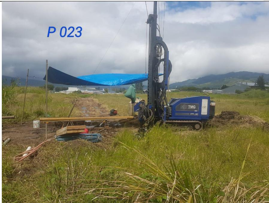
*Proceso de la perforación P-23, equipo de rotación instalado en una zona con vegetación baja, de topografía bastante plana, y sin edificaciones.*
