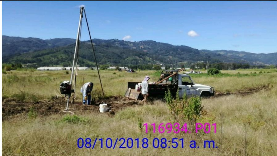
*Proceso de la perforación P-1, realizada en una zona con vegetación baja, de topografía bastante plana, y sin edificaciones.*
