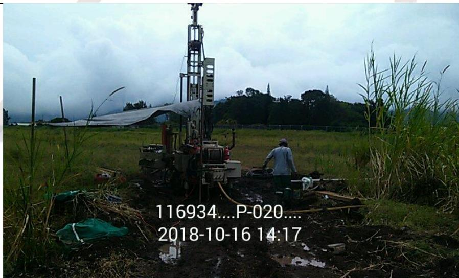
*Proceso de la perforación P-20, equipo de rotación instalado en una zona con vegetación baja, de topografía bastante plana, y sin edificaciones.*
