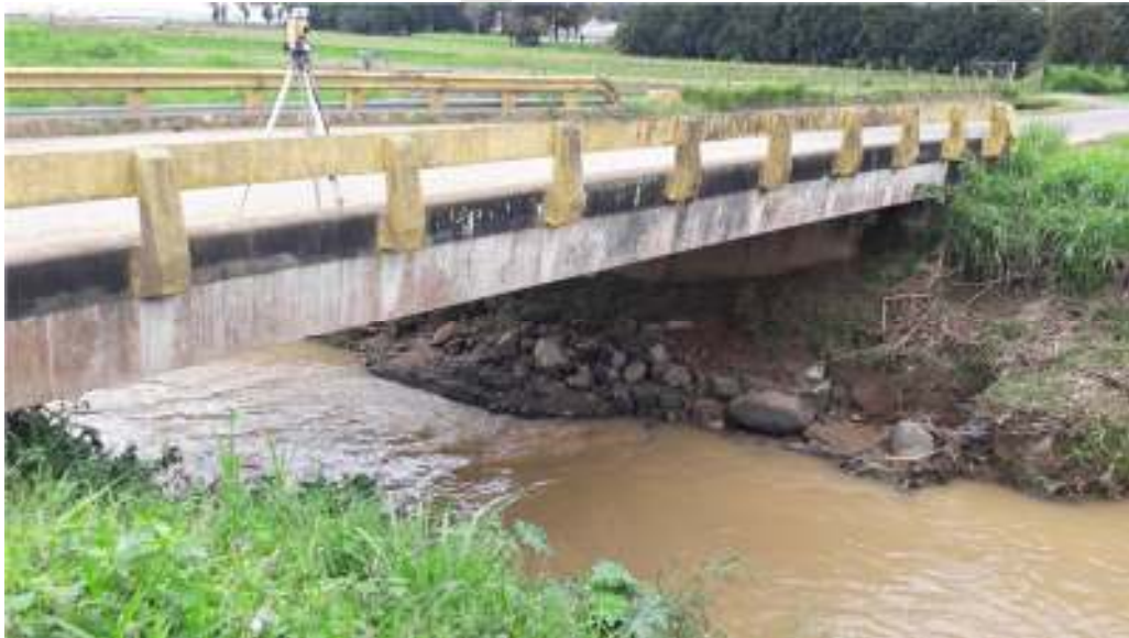
Puente sobre el río Purires
