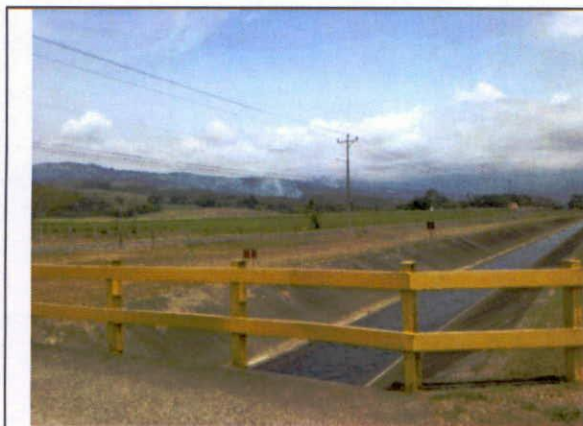
Fotografía 7.8. Cauce canalizado para el abastecimiento del embalse La Angostura, hacia la izquierda de la imagen, se observa el AP.
