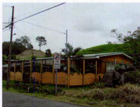
Fotografía 9.2 Vivienda en Eslabón.
