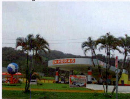
Fotografía 9.4 Estación de Servicio a la entrada de Eslabón.
