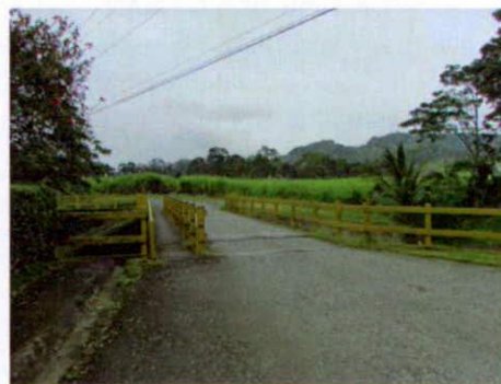
Fotografía 9.12 Puente sobre el canal que conduce aguas al Embalse La Angostura (50 metros al Noreste del vértice Norte del AP).
