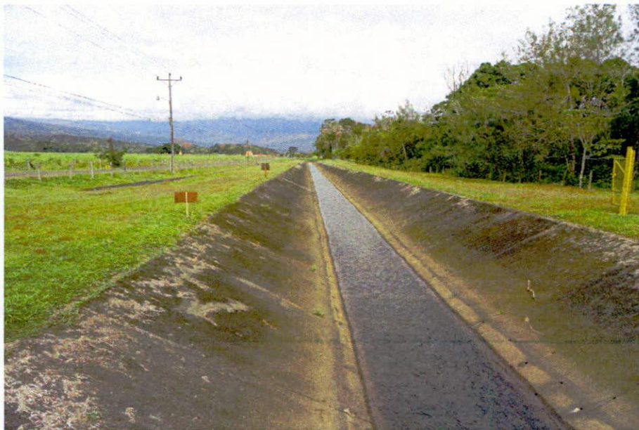
Fotografía 5.3. Vista del canal existente en las cercanías del Área de Proyecto
