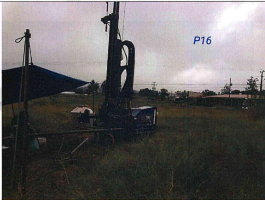
Proceso de la perforación P-16, equipo de rotación instalado en una zona con vegetación baja, de topografía bastante plana, y sin edificaciones.
