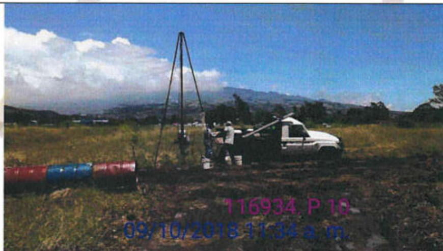
Proceso de la perforación P-10, realizada en una zona con vegetación baja, de topografía bastante plana, y sin edificaciones.
