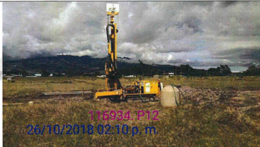
Proceso de la perforación P-12, equipo de rotación instalado en una zona con vegetación baja, de topografía bastante plana, y sin edificaciones.
