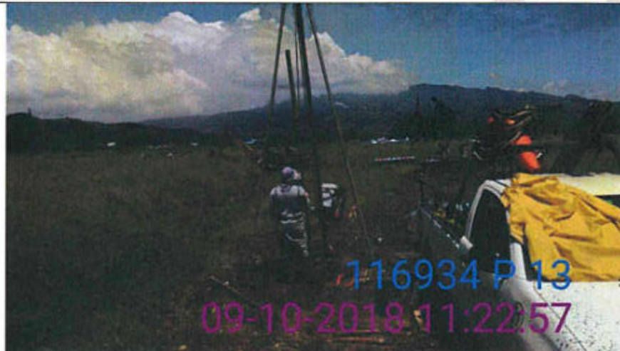
Proceso de la perforación P-13, realizada en una zona con vegetación baja, de topografía bastante plana, y sin edificaciones.
