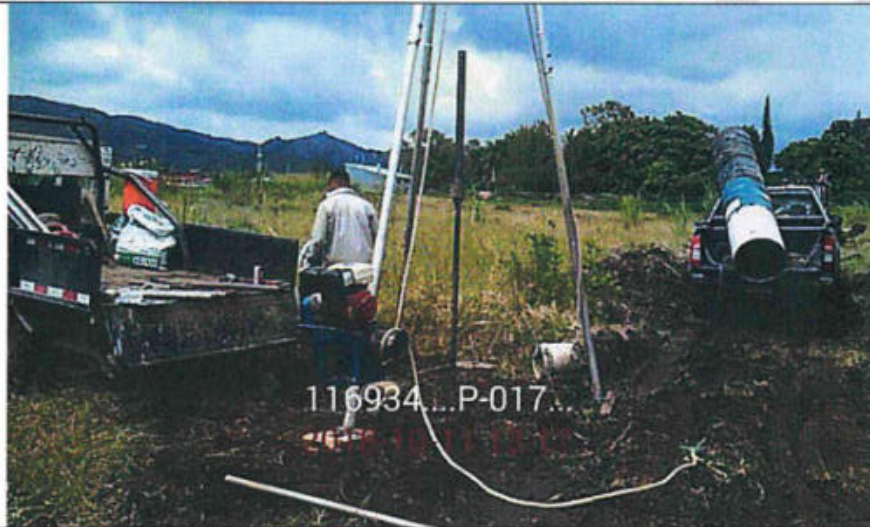
Proceso de la perforación P-17, realizada en una zona con vegetación baja, de topografía bastante plana, y sin edificaciones.
