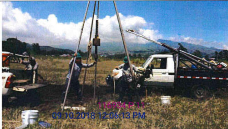
Proceso de la perforación P-11, realizada en una zona con vegetación baja, de topografía bastante plana, y sin edificaciones.
