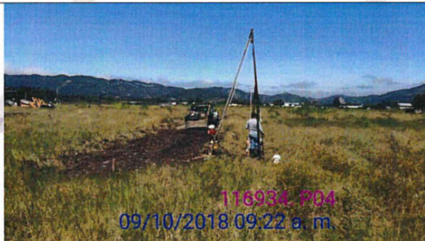
Proceso de la perforación P-4, realizada en una zona con vegetación baja, de topografía bastante plana, y sin edificaciones.
