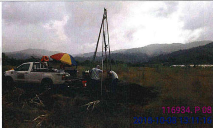
Proceso de la perforación P-8, realizada en una zona con vegetación baja, de topografía bastante plana, y sin edificaciones.
