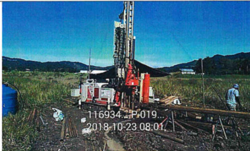
Proceso de la perforación P-19, equipo de rotación instalado en una zona con vegetación baja, de topografía bastante plana, y sin edificaciones.
