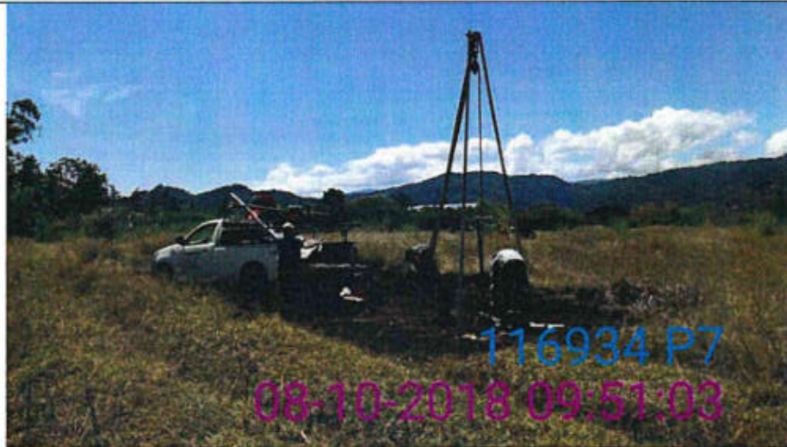
Proceso de la perforación P-7, realizada en una zona con vegetación baja, de topografía bastante plana, y sin edificaciones.
