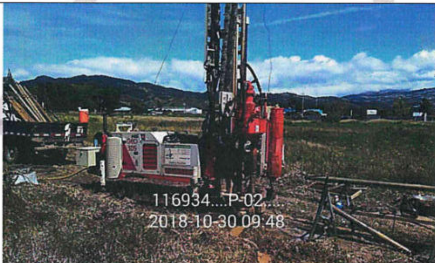
Proceso de la perforación P-2, equipo de rotación instalado en una zona con vegetación baja, de topografía bastante plana, y sin edificaciones.
