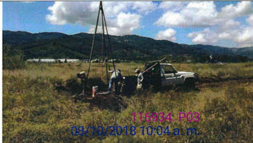
Proceso de la perforación P-3, realizada en una zona con vegetación baja, de topografía bastante plana, y sin edificaciones.
