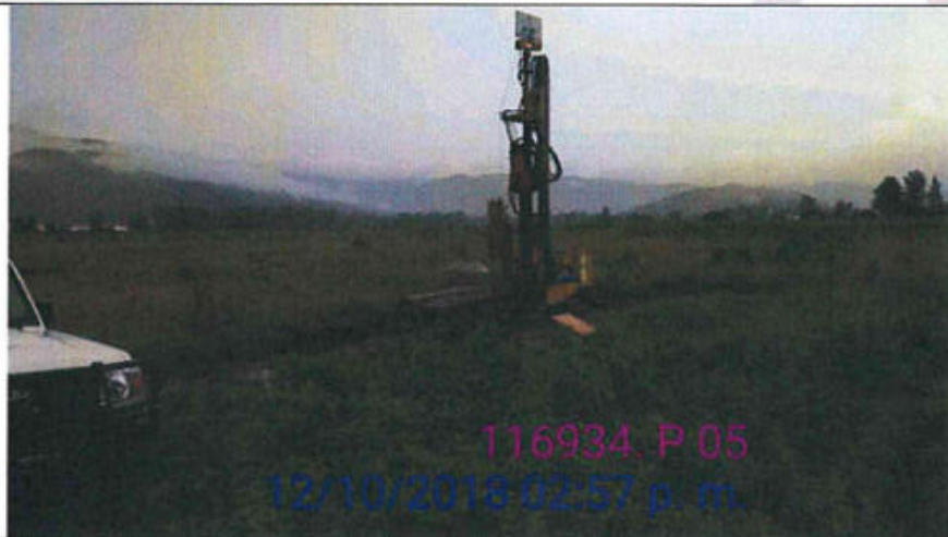
Proceso de la perforación P-5, equipo de rotación instalado en una zona con vegetación baja, de topografía bastante plana, y sin edificaciones.
