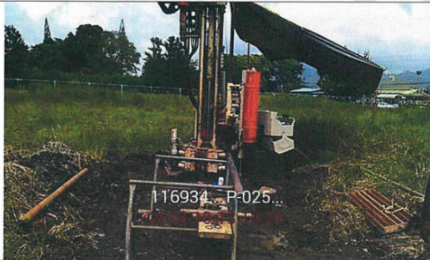
Proceso de la perforación P-25, equipo de rotación instalado en una zona con vegetación baja, de topografía bastante plana, y sin edificaciones.
