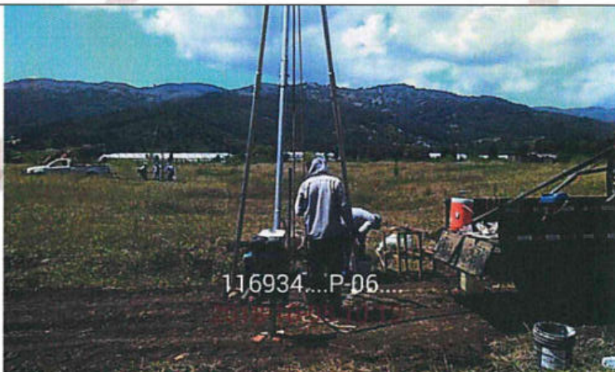
Proceso de la perforación P-6, realizada en una zona con vegetación baja, de topografía bastante plana, y sin edificaciones.
