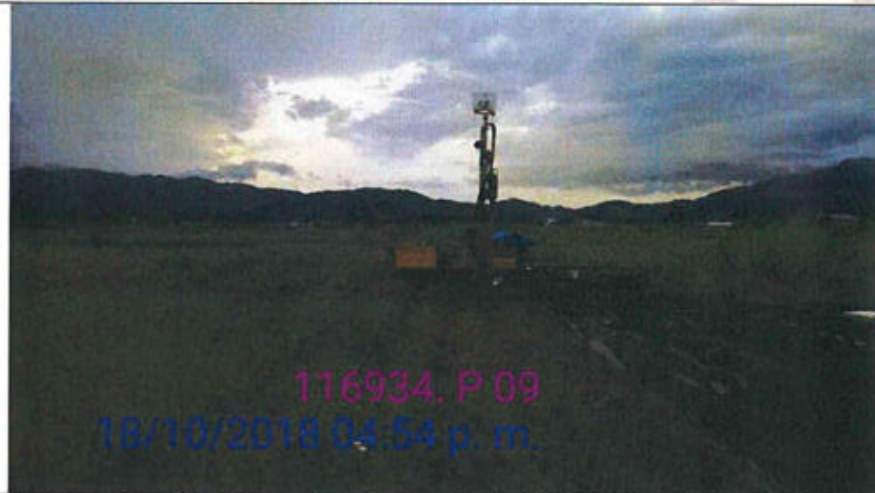
Proceso de la perforación P-9, equipo de rotación instalado en una zona con vegetación baja, de topografía bastante plana, y sin edificaciones.
