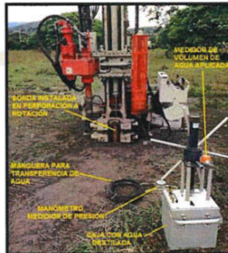
Figura 2.4.4.- Instalación de equipo para prueba presiométrica dentro del hueco de perforación a rotación.
