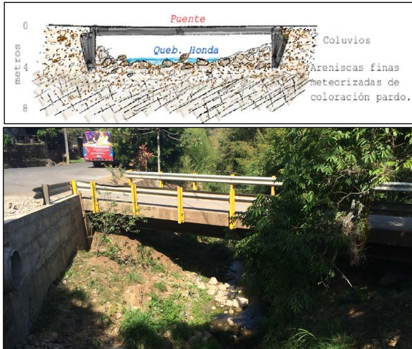
**Figura 7.1.89.** Esquema de las Unidades Geotécnicas y detalle del sitio en el paso PRQ-3. (Coordenadas CRTM05 Norte 1091968 Este 497628).
